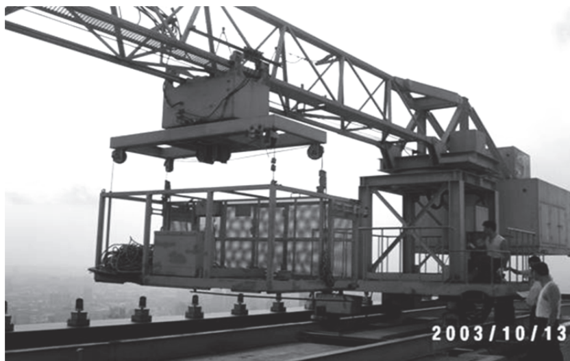
圖 1-1 吊臂固定型吊籠(軌道式，工作台式，本體旋轉)
