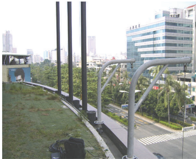
圖 1-8 懸臂型吊籠(固定式，操作台式)
