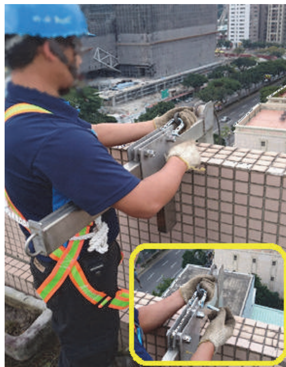
圖 4-33 F 型支架-施放吊籠卸放用鋼索
