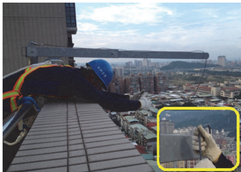
圖 4-57 座地式-施放吊籠卸放用鋼索
