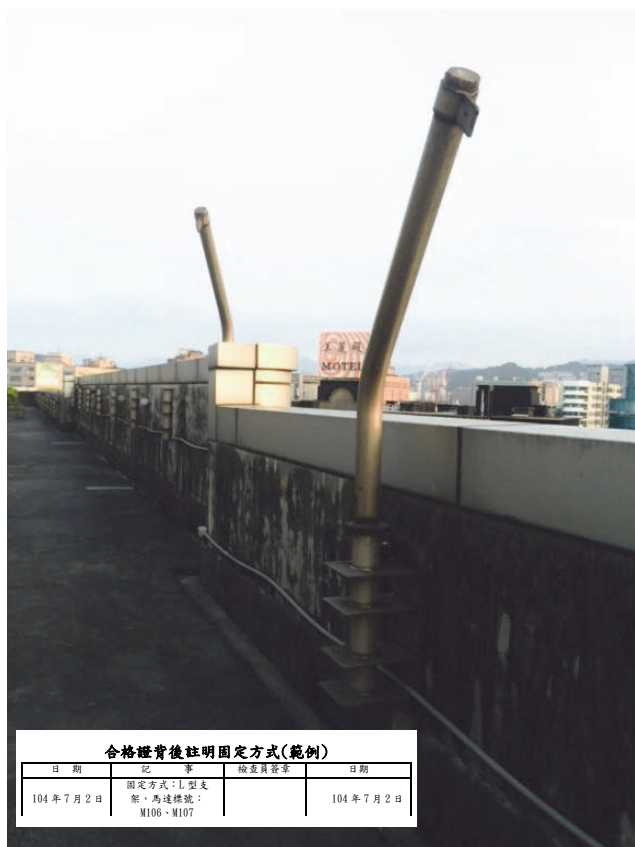
圖 4-77 固定方式與合格證背面註明固定方式不同， 辦理變更檢查合格後方可使用
