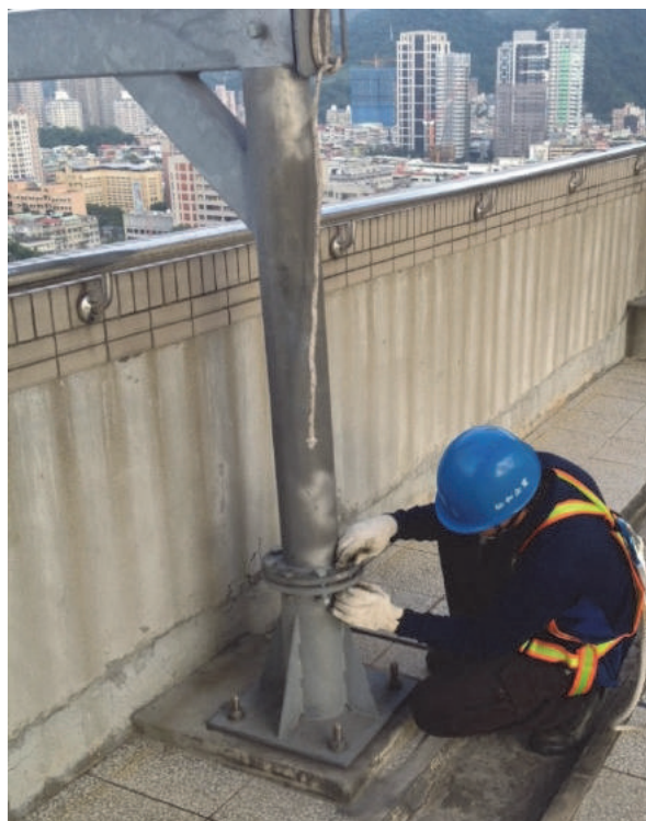
圖 4-56 座地式吊臂安裝檢查
