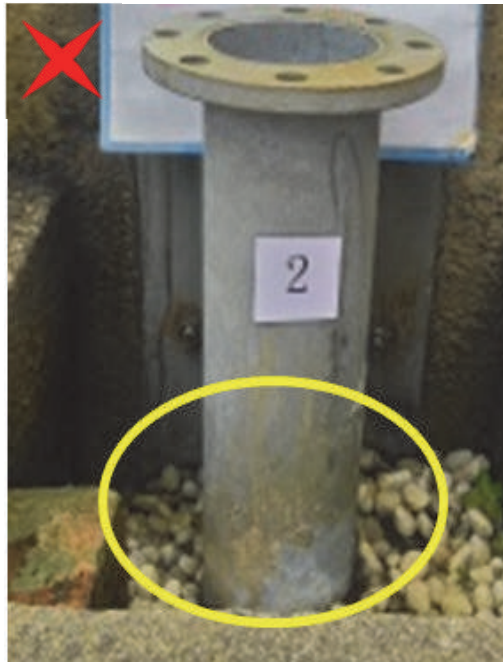
圖 7-30 基座底部不應被石礫填滿
