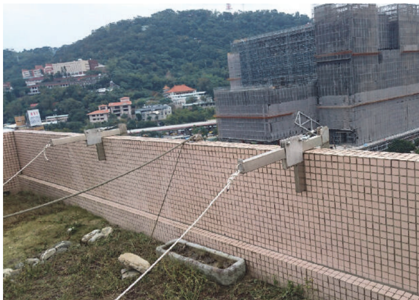
圖 4-35 F 型支架-支架安裝完成
