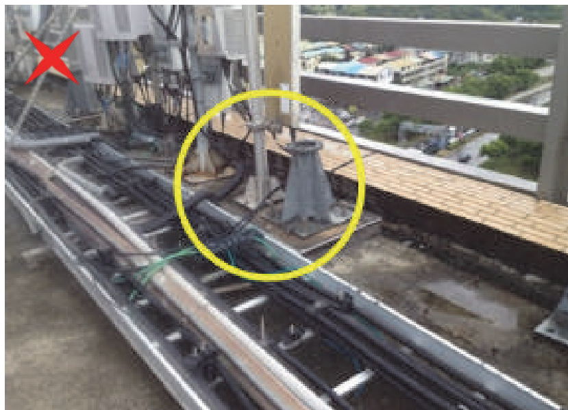
圖 7-27 基座附近不應有散落電線
