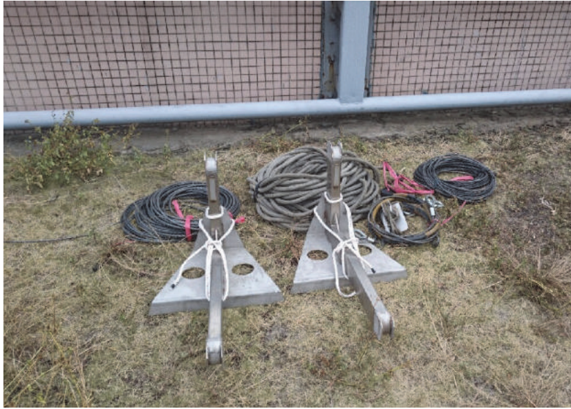
圖 4-36 L 型支架-屋頂安裝準備
