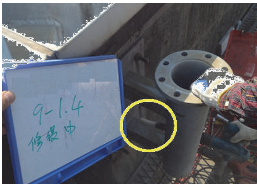
圖 7-17 基礎螺栓第四點未達測試值被拉出-注射化學藥劑
