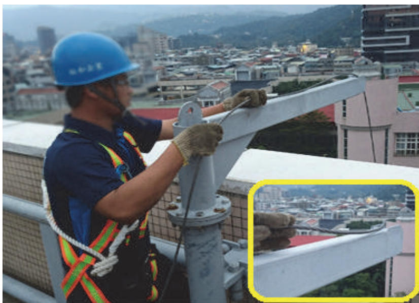
圖 4-49 扶壁式-施放吊籠卸放用鋼索
