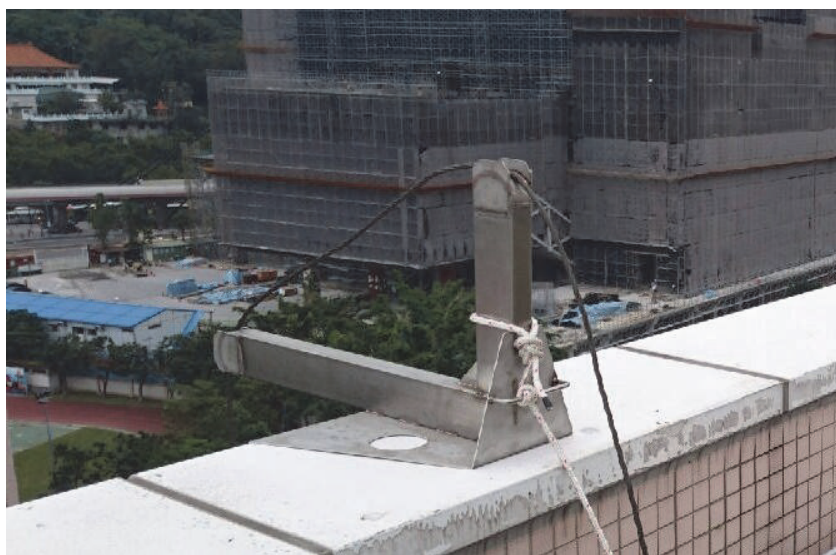
圖 4-43 L 型支架-支架安裝完成
