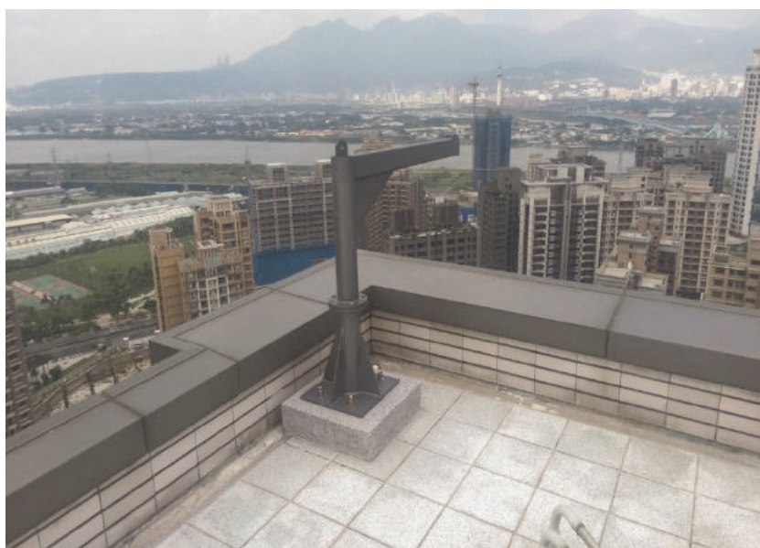
圖 6-4 座地式基座及 RC 土墩完成狀態
