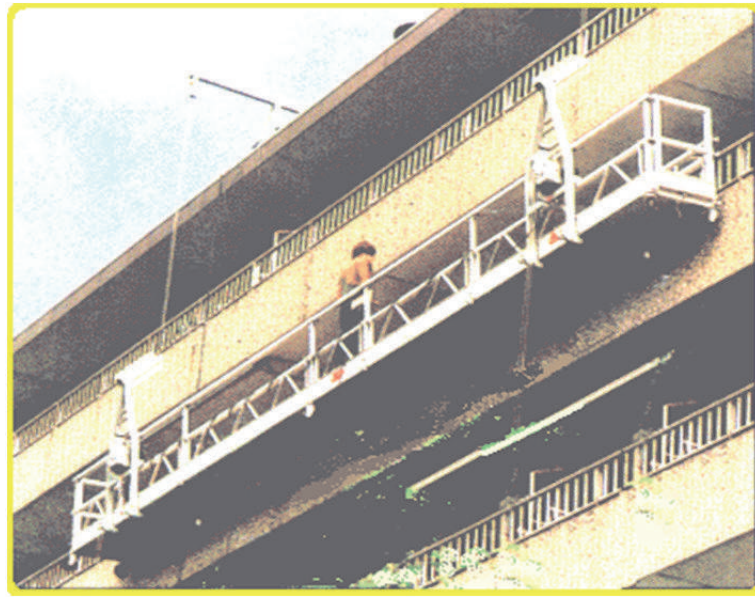
圖 1-10 懸臂型吊籠(操作台式)
