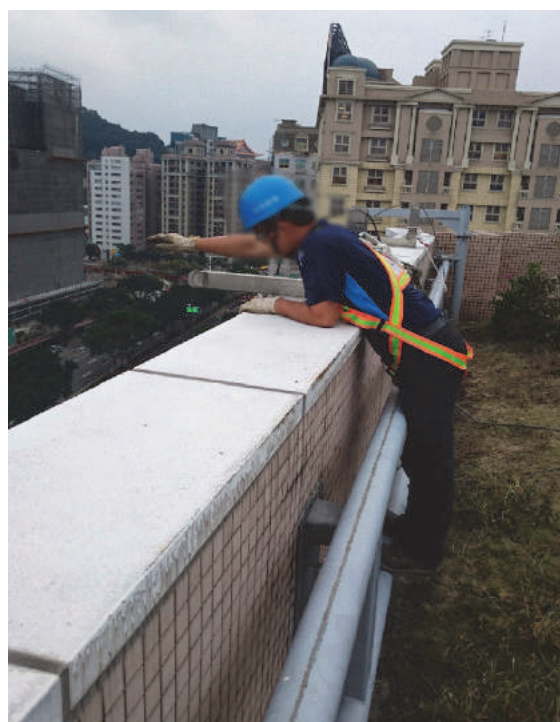
圖 4-41 L 型支架-施放吊籠卸放用鋼索
