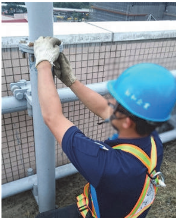
圖 4-47 扶壁式-吊臂安裝
