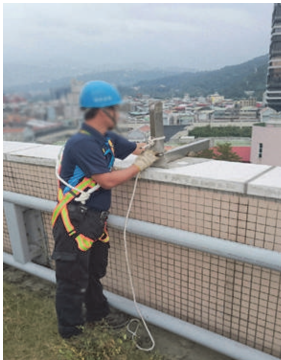
圖 4-39 L 型支架-屋頂架設置支架
