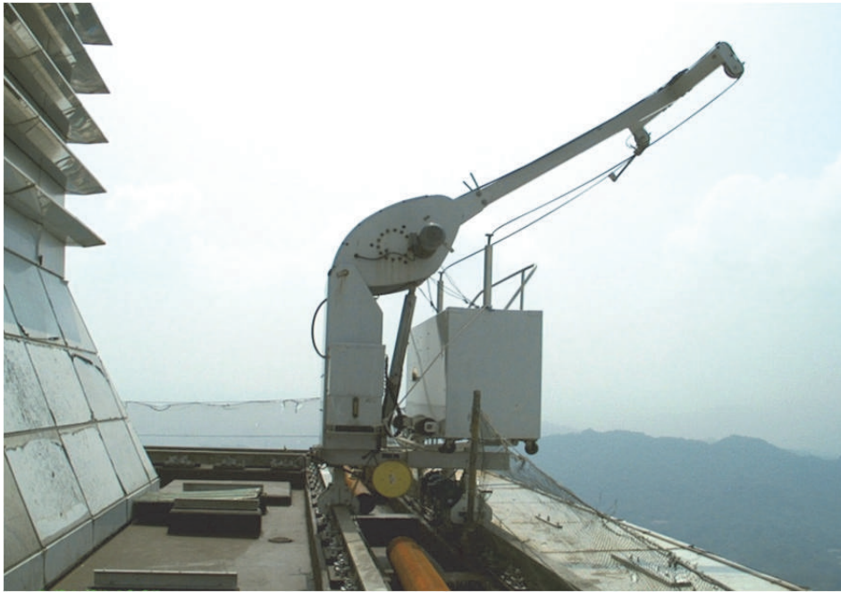
圖 1-4 吊臂俯仰型吊籠(軌道式，工作台式)
