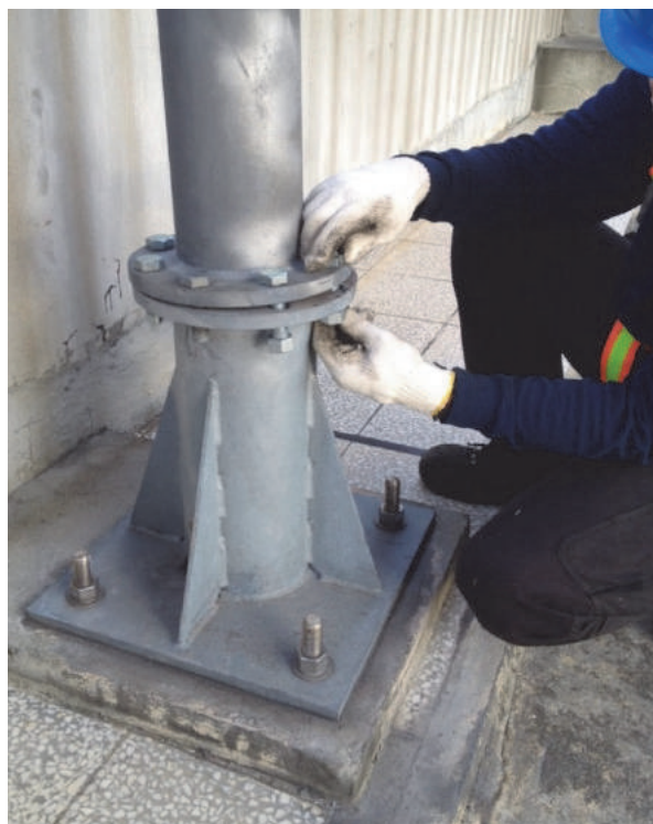
圖 4-55 座地式-吊臂安裝
