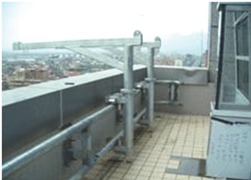
圖 1-11 懸臂型吊籠(軌道式，操作台式)
