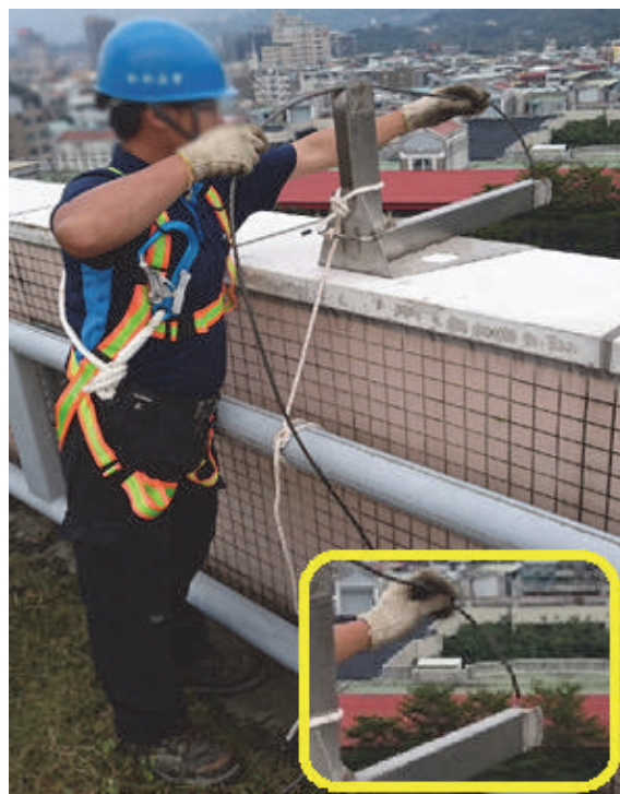
圖 4-40 L 型支架-施放吊籠卸放用鋼索
