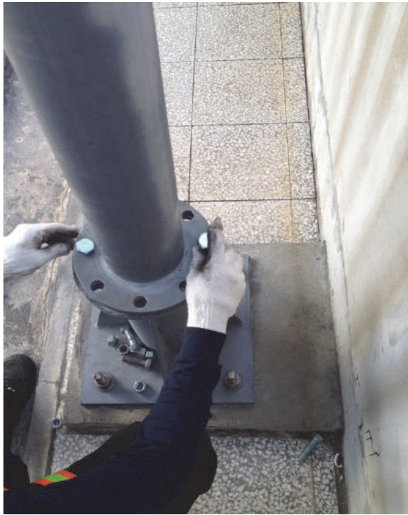
圖 4-54 座地式-吊臂安裝
