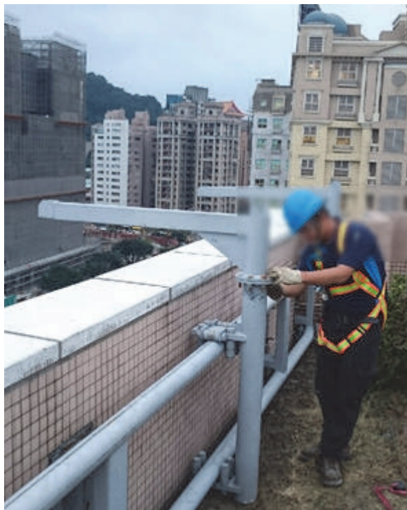
圖 4-46 扶壁式-吊臂安裝
