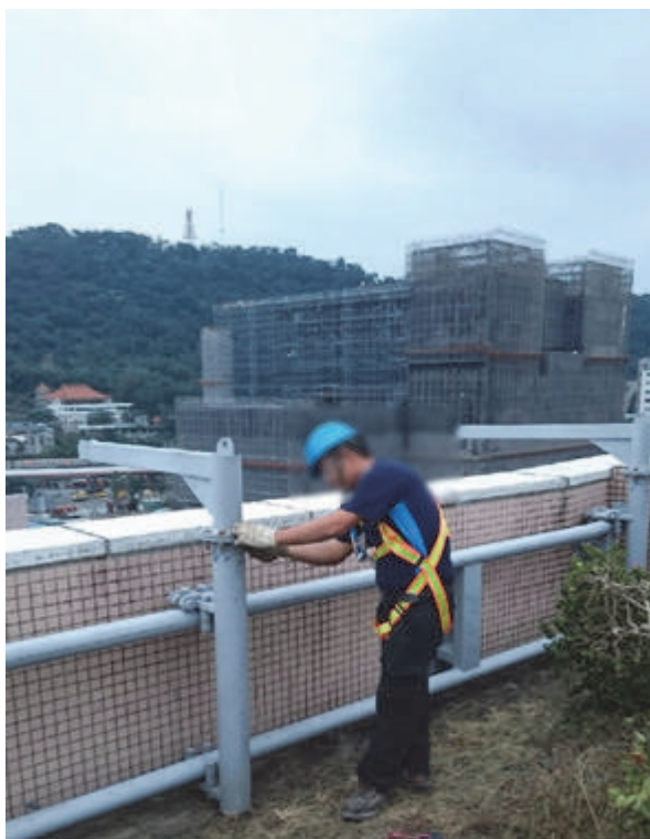
圖 4-48 扶壁式-吊臂安裝檢查
