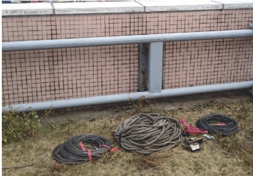
圖 4-44 扶壁式-屋頂施放救命索
