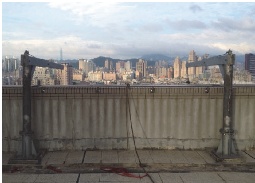
圖 4-58 座地式-吊臂安裝完成
