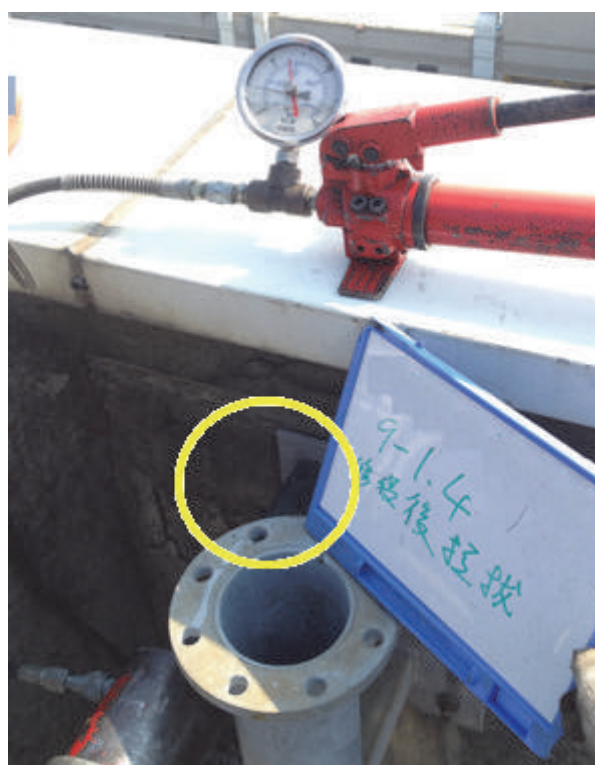
圖 7-13 基礎螺栓第一點未達測試值被拉出-修復後重新拉拔試驗合格
