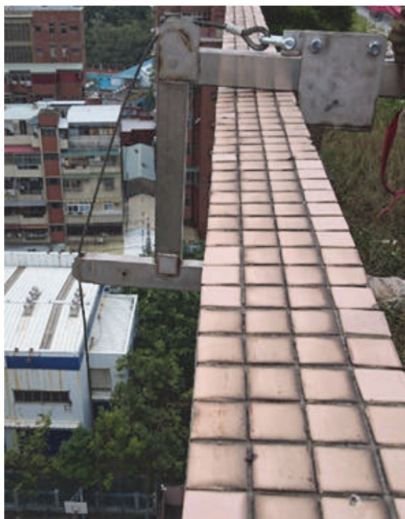
圖 4-34 F 型支架-支架安裝完成
