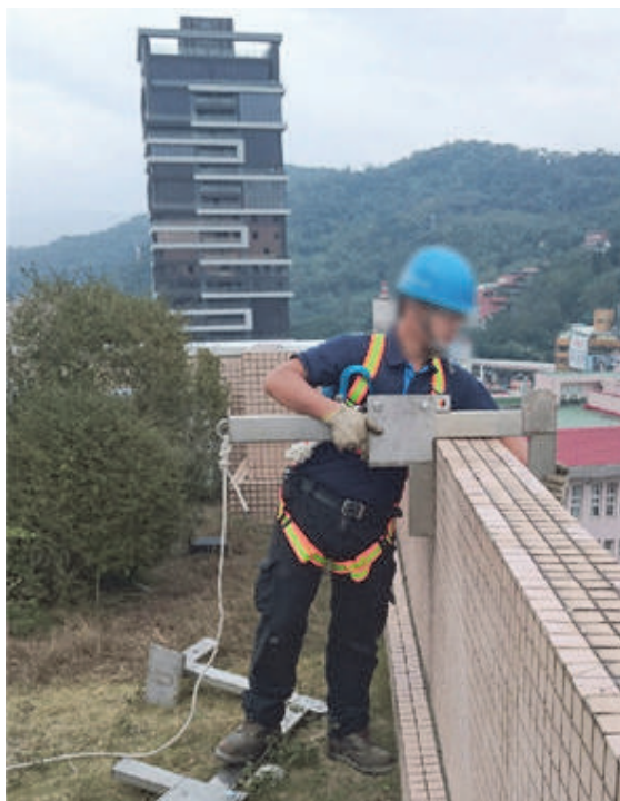
圖 4-31 F 型支架-屋頂架設置支架
