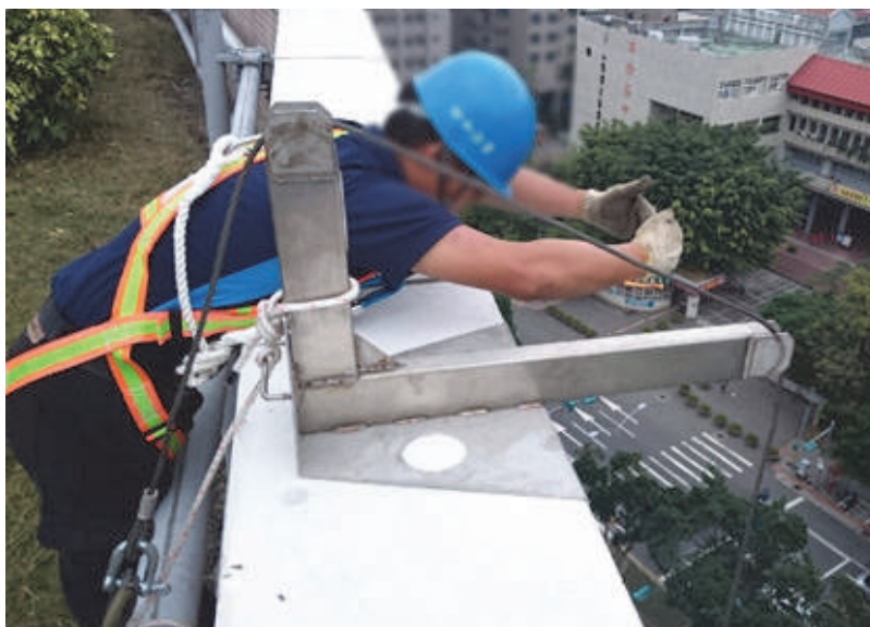
圖 4-42 L 型支架-支架安裝完成
