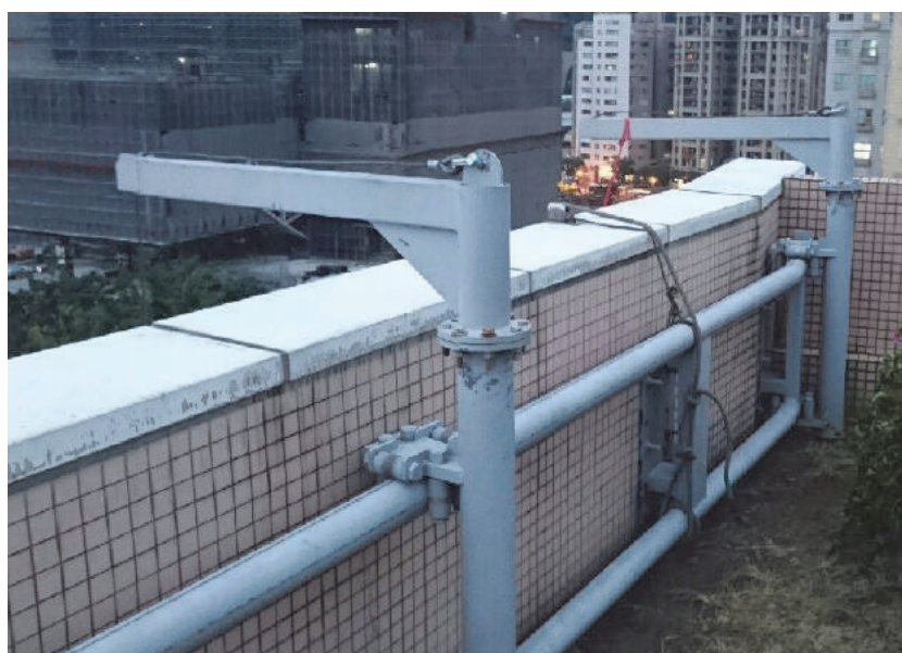
圖 4-51 扶壁式-吊臂安裝完成
