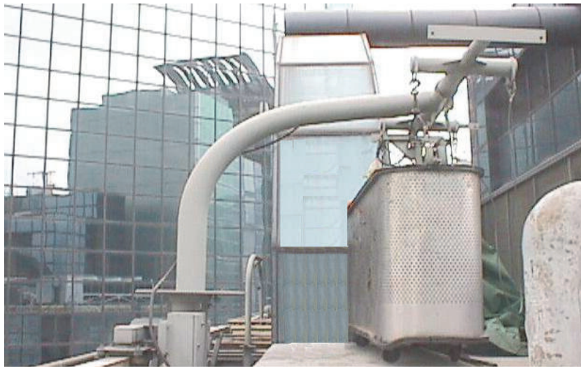
圖 1-2 吊臂固定型吊籠(軌道式，工作台式，本體旋轉)
