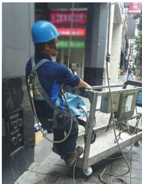
圖 4-68 救命用纖維索試拉測試
