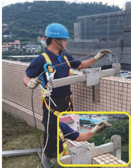
圖 4-32 F 型支架-施放吊籠卸放用鋼索
