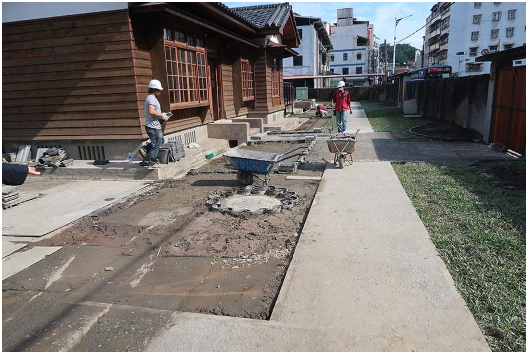
▶ 施工中之「前庭院」。
