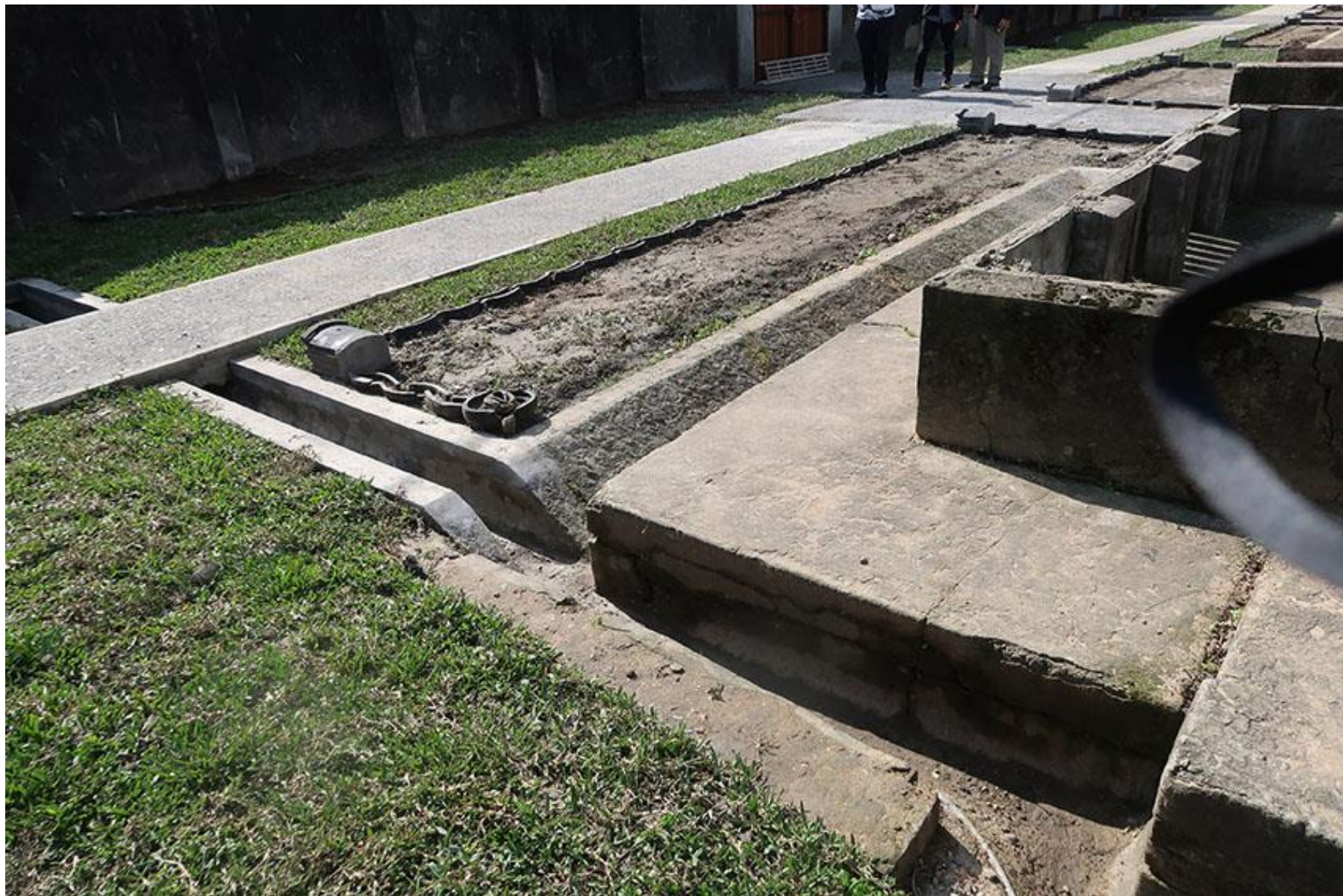
▶ 113號建築物之「排水溝」。
