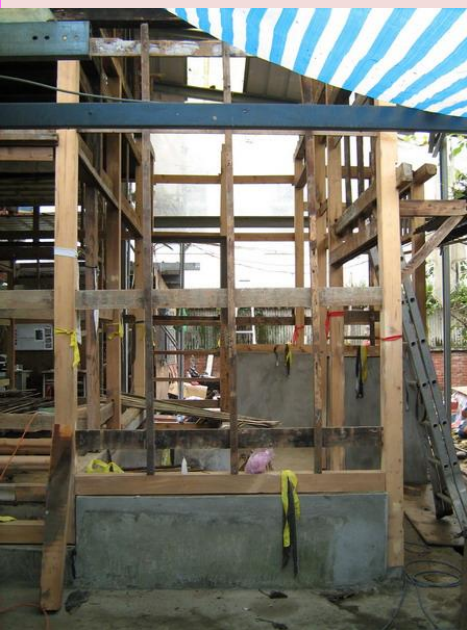
施工前-裝上貫木
