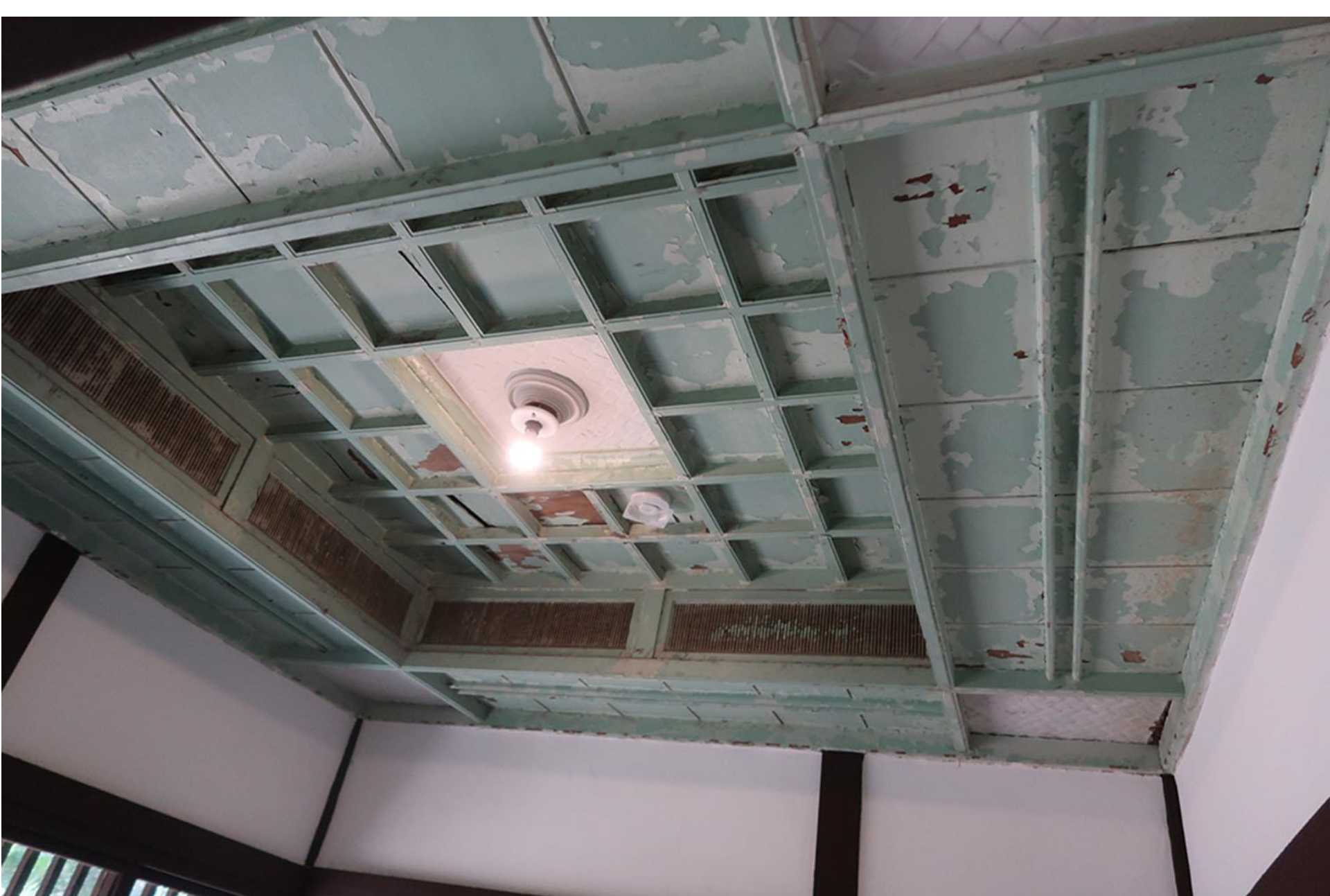
◆ 嚴家淦故居...風呂之天井
