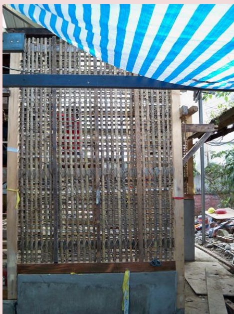
施工中-竹筋綁紮
