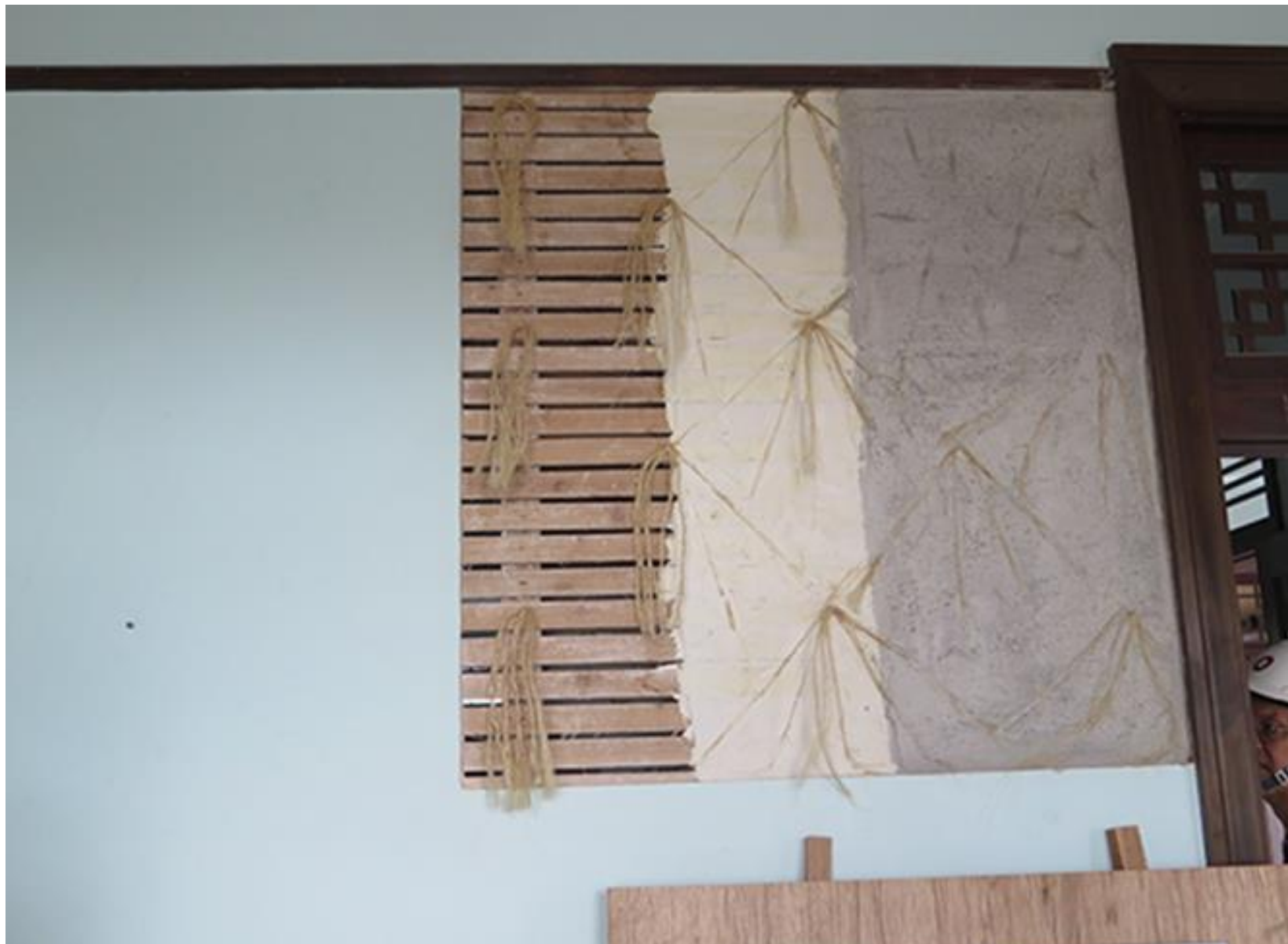
◆ 北埔 姜阿新宅第…木褶牆工法試作
