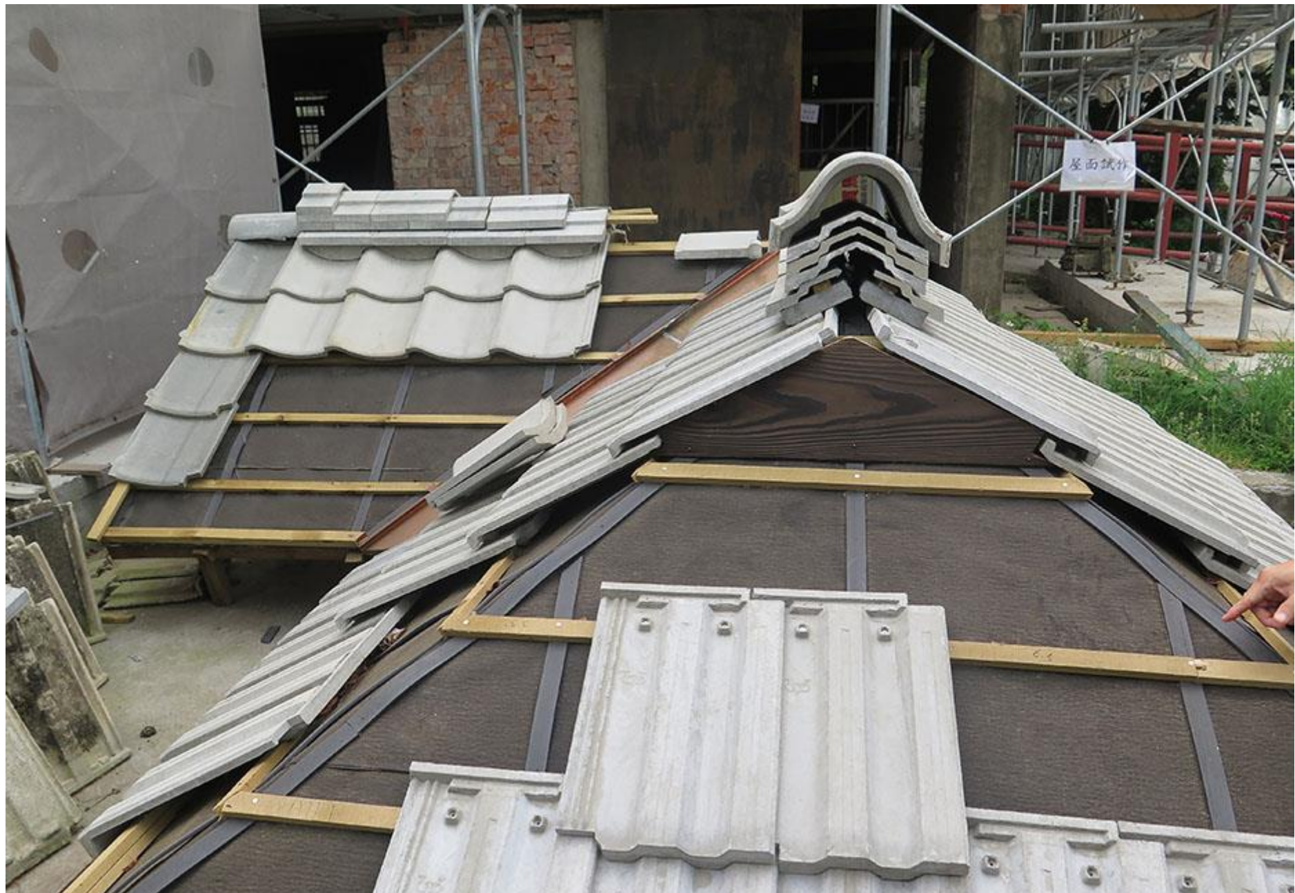
▶ 黑瓦、水泥瓦工法試作
