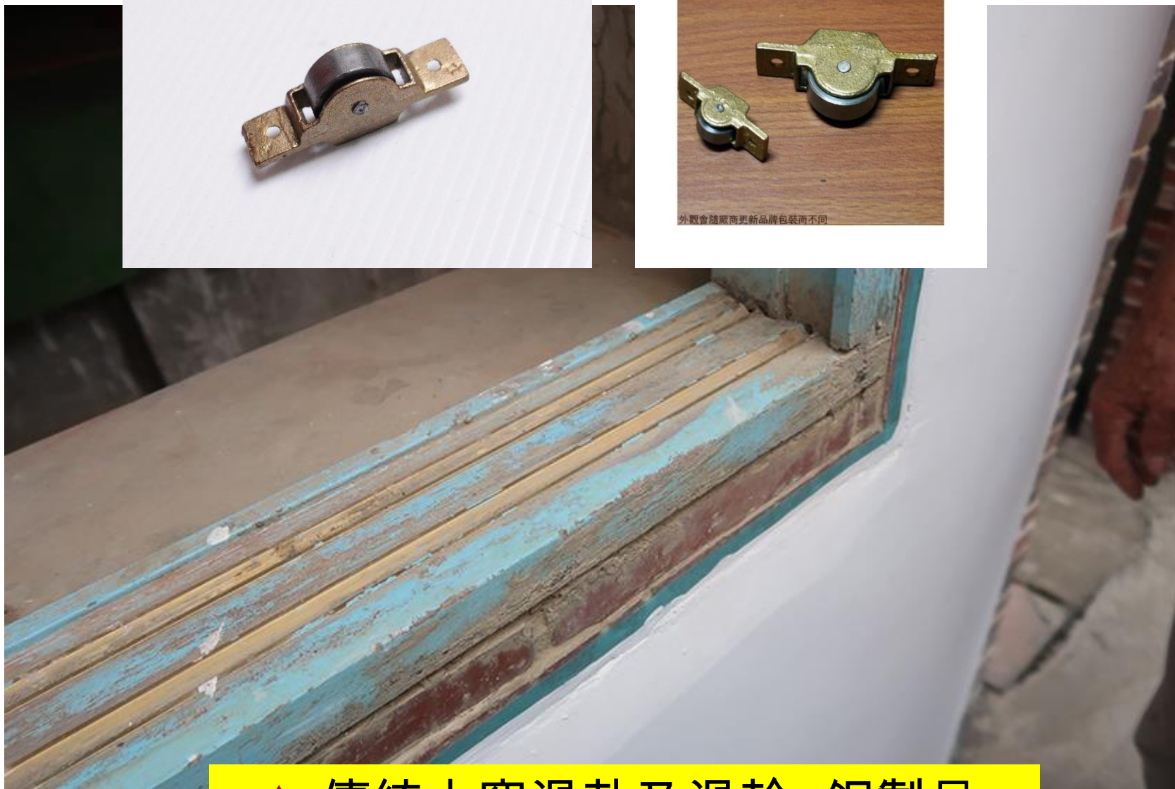
▲ 傳統木窗滑軌及滑輪<銅製品>
