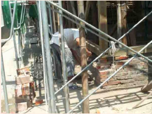
【照1-1】原有土台拆除
