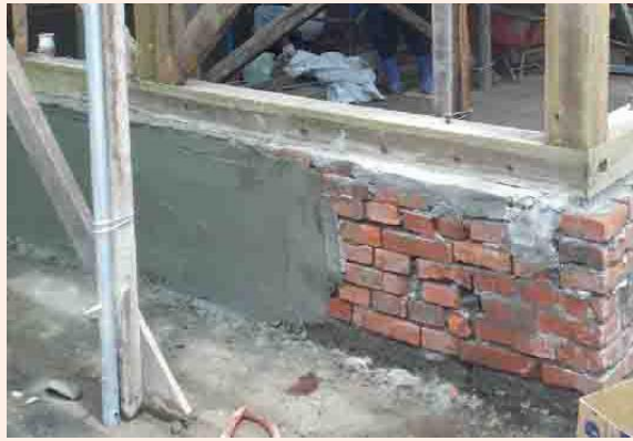
【照1-5】表面粉刷施作
