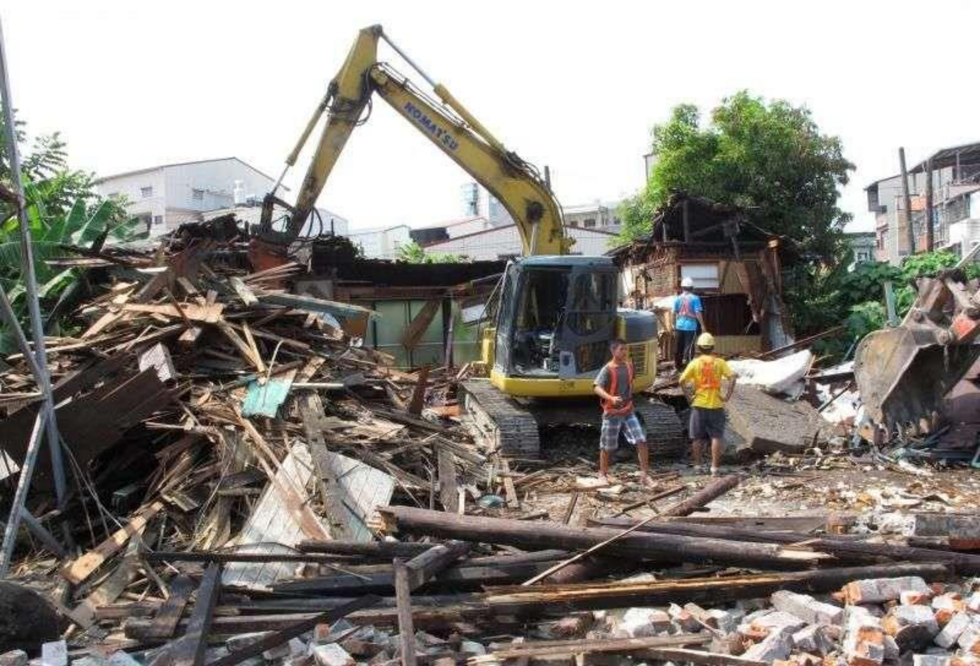
◆ 旗山日治時期警察分局長宿舍〈高市水利局拆除〉 53
