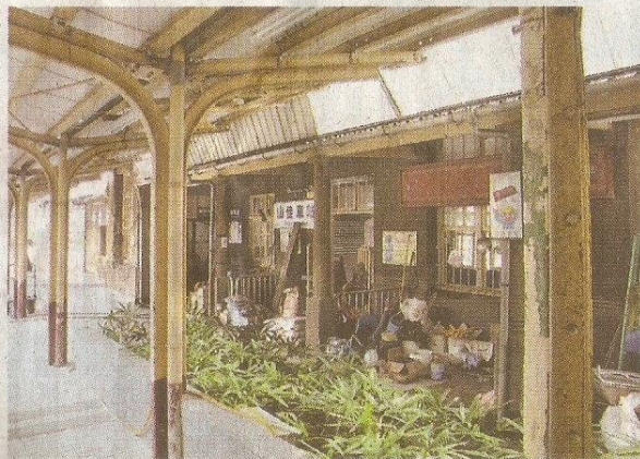
←鐵軌鋼架製成的月台遮雨棚，多處已生鏽掉漆。 (記者謝佳君攝)
