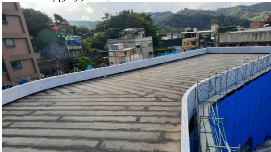
屋頂層防水層
