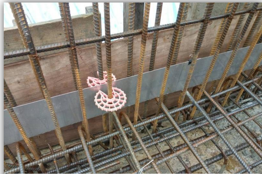
外牆層間接縫施作不銹鋼止水版
