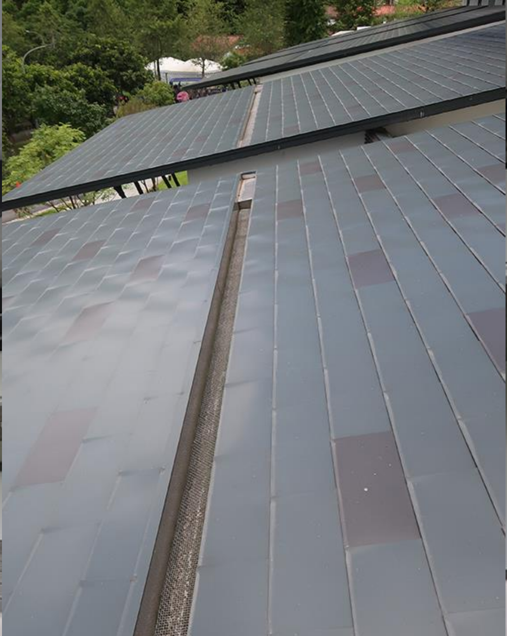
◆ 斜屋面鋼構工法、屋面截水溝
