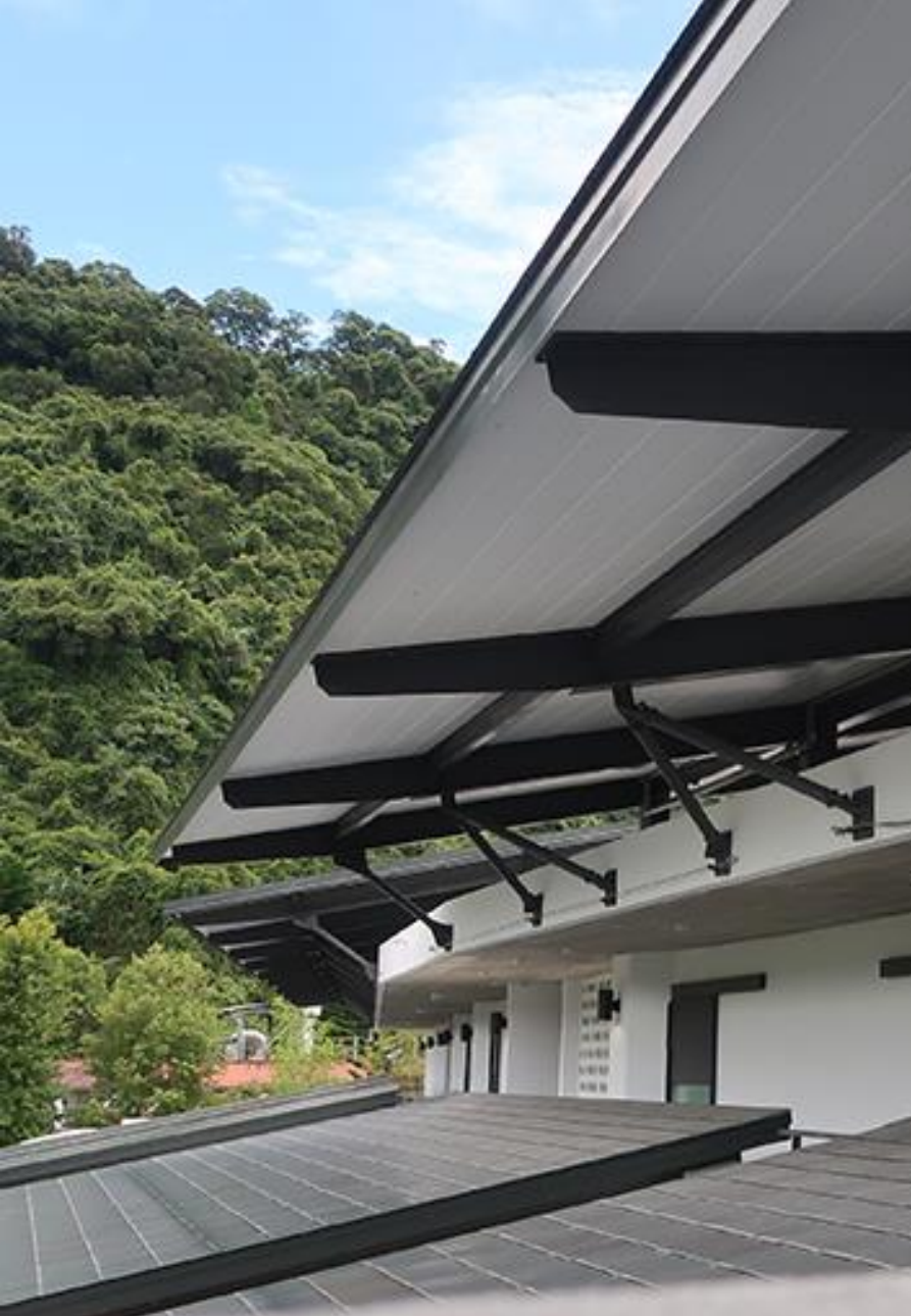
◆ 斜屋面鋼構工法、屋面截水溝
