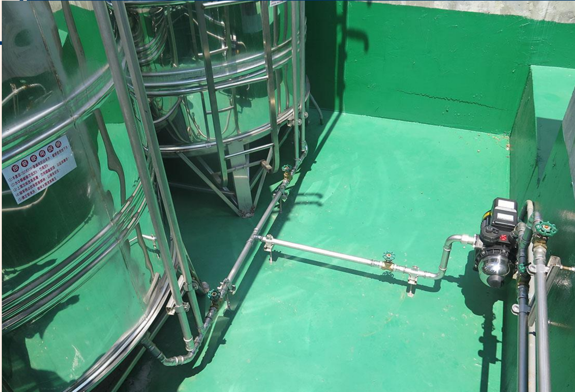
◆ 水箱腳架，破壞防水層。〈不佳〉
