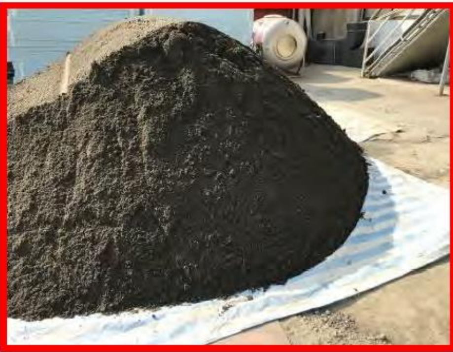
泥作用砂防水布隔離
