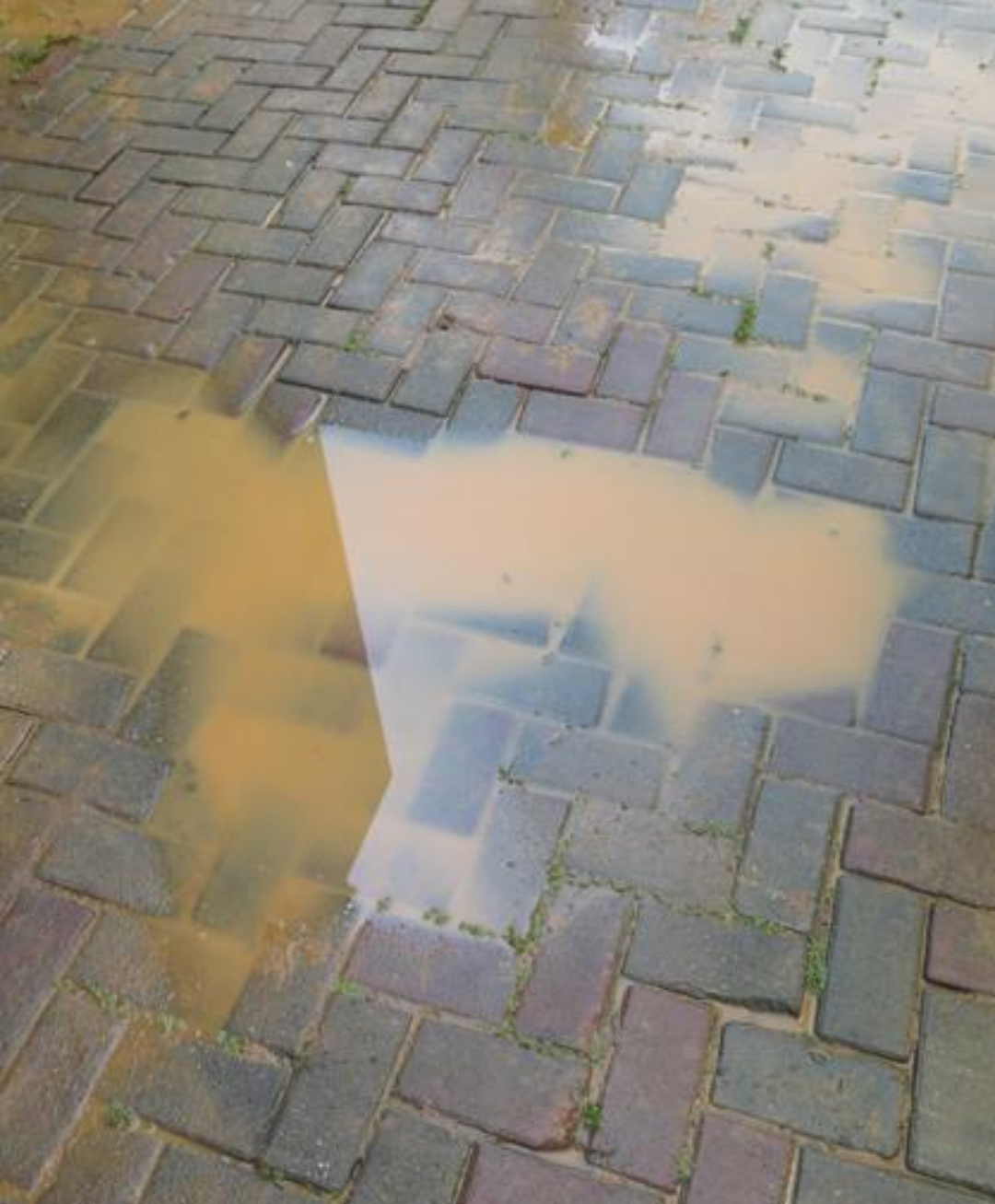
◆ 高壓水泥磚軟底施工，不均勻沉陷導致積水。
