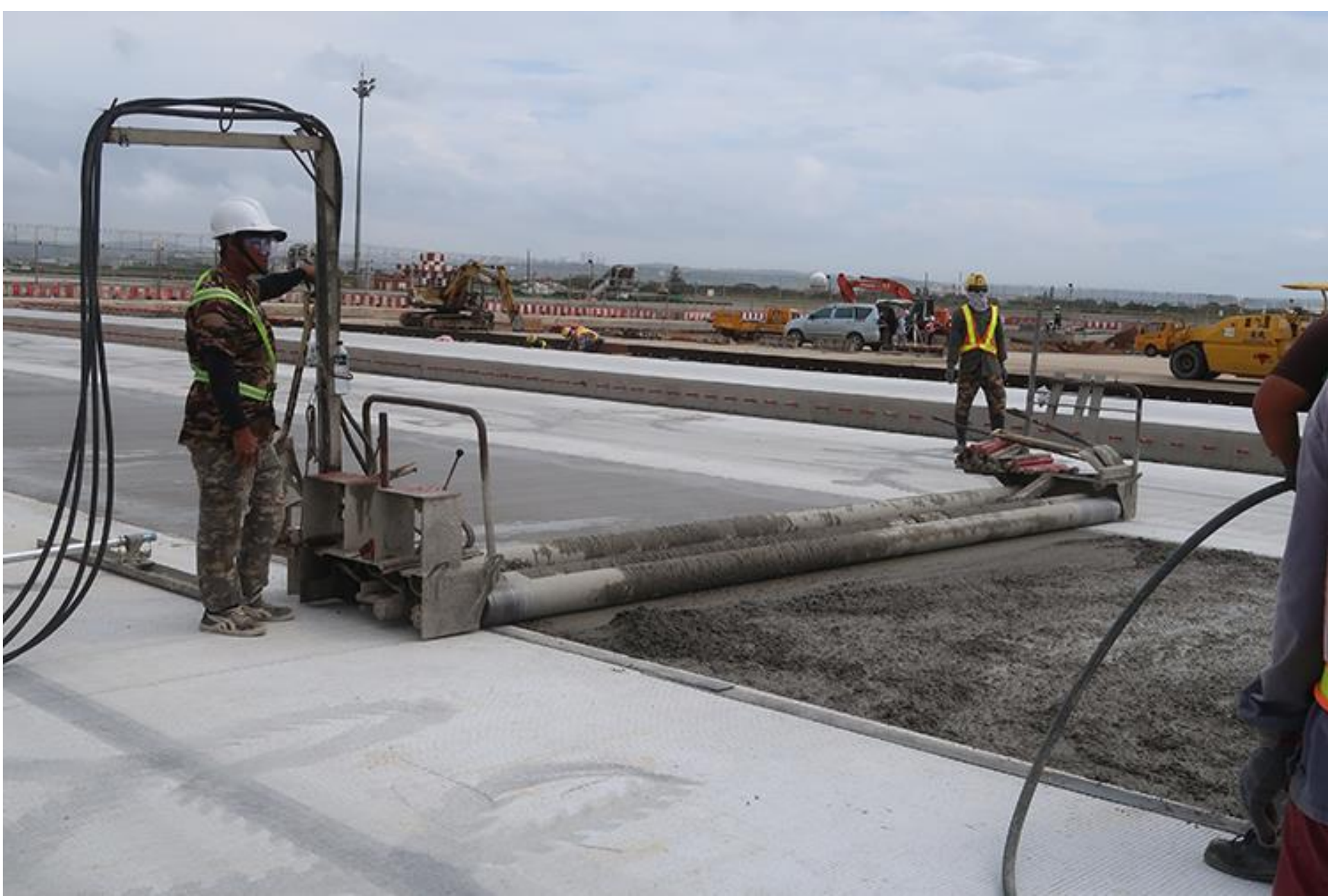
◆ 機場停機坪.剛性混凝土整平機。(46cm TH) 127
