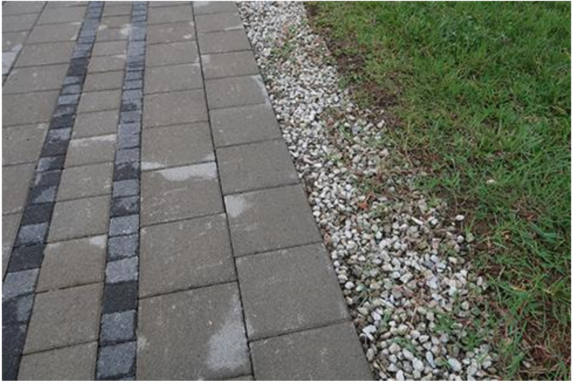
◆ 高壓混凝土磚地坪與草皮之界面
