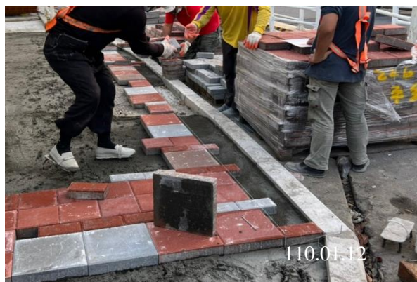
▶ 放樣後鋪貼透水磚
