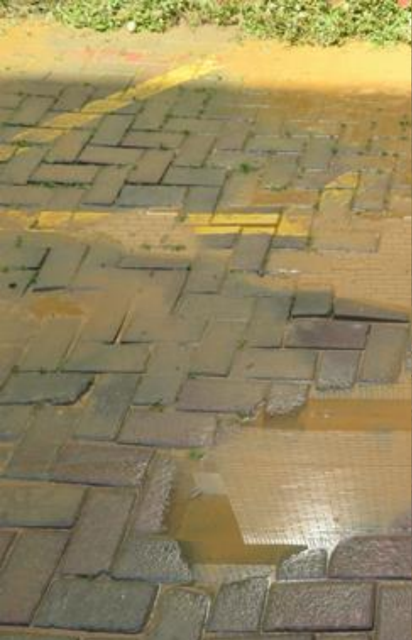
◆ 高壓水泥磚軟底施工，不均勻沉陷導致積水。
