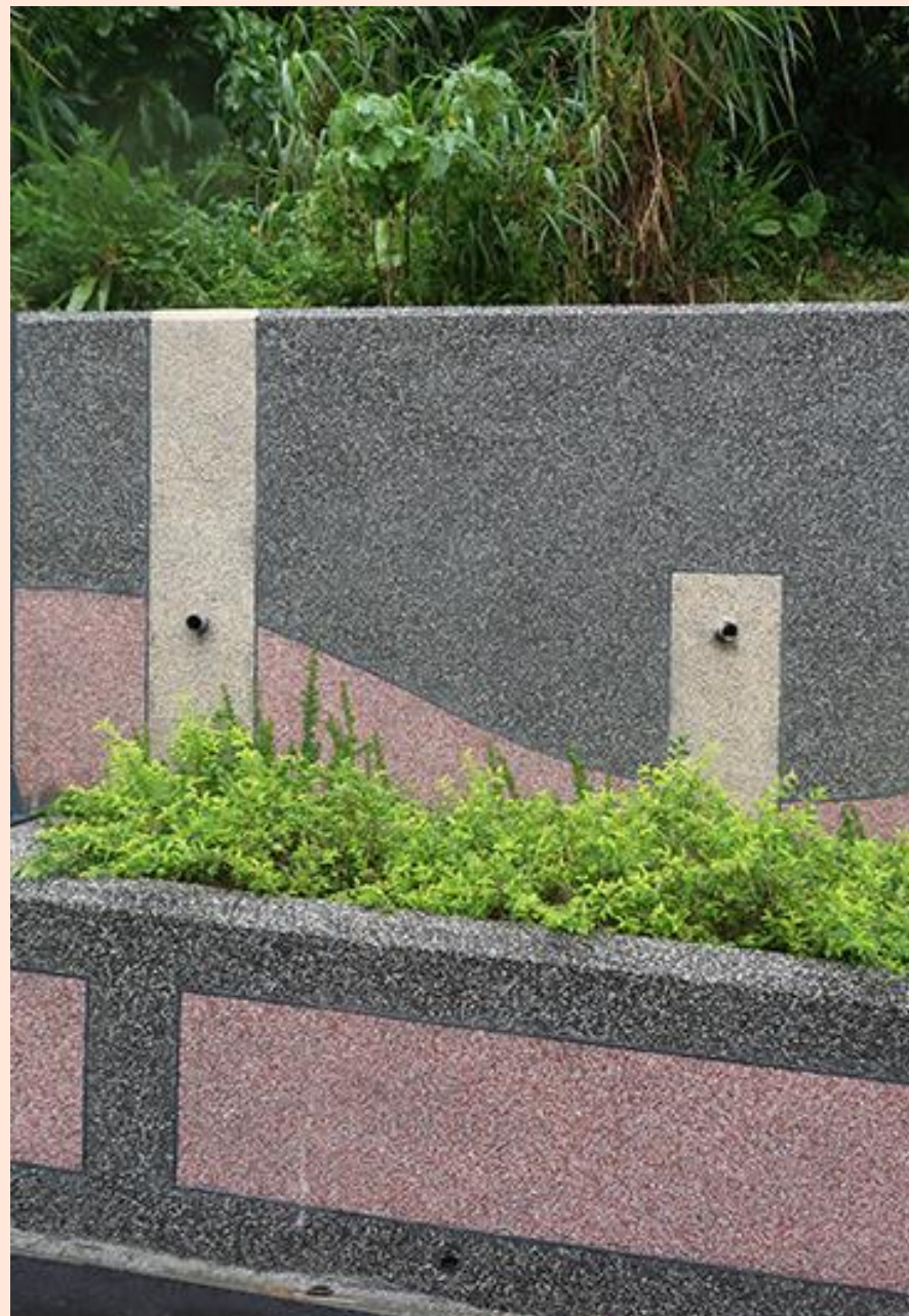
◆ 擋土牆洩水孔美化
