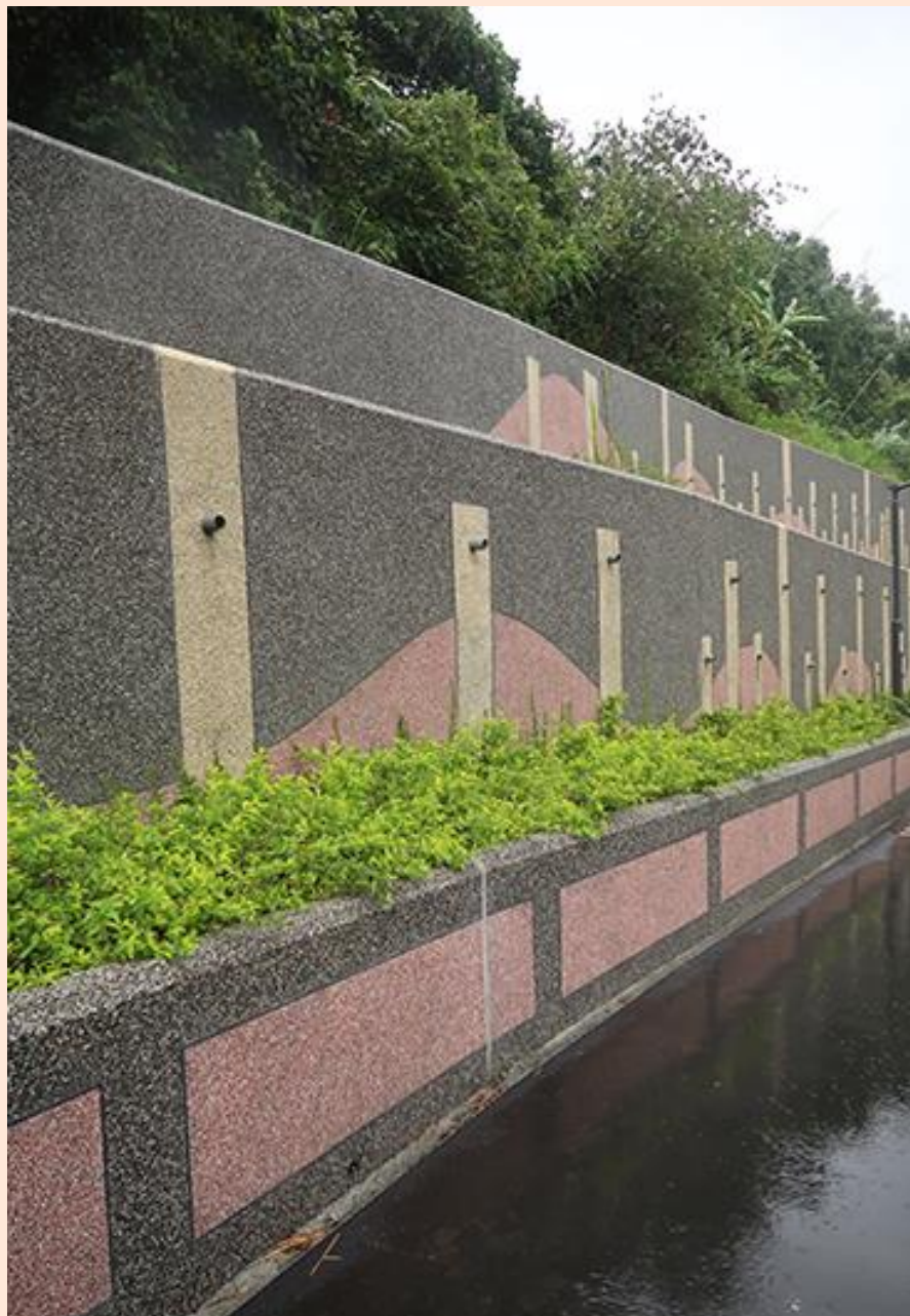
◆ 擋土牆洩水孔美化
