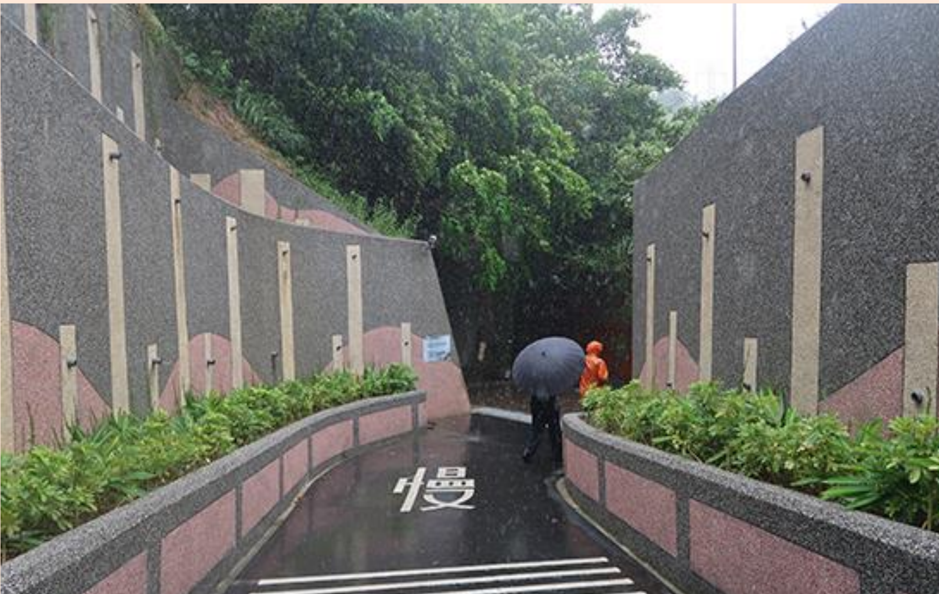
◆ 擋土牆洩水孔美化
