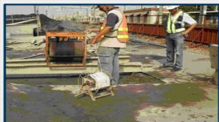
鑽掘深度確認
