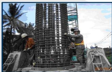
鋼筋籠吊放
