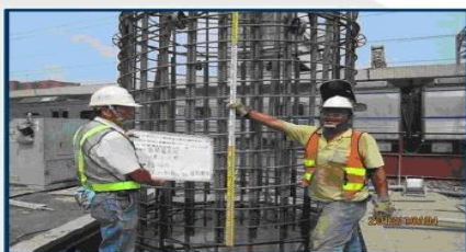
鋼筋籠吊放
