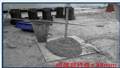
混凝土坍度檢測
