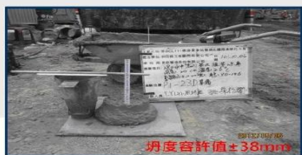
混凝土坍度檢測
