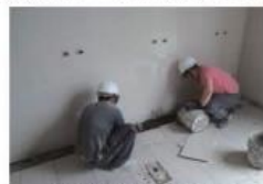
浴廁空間鋪貼止滑磚
