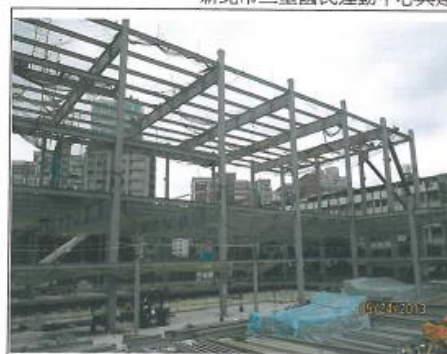
新北市三重國民運動中心興建統包工程
