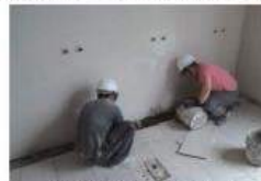
浴廁空間鋪貼止滑磚
