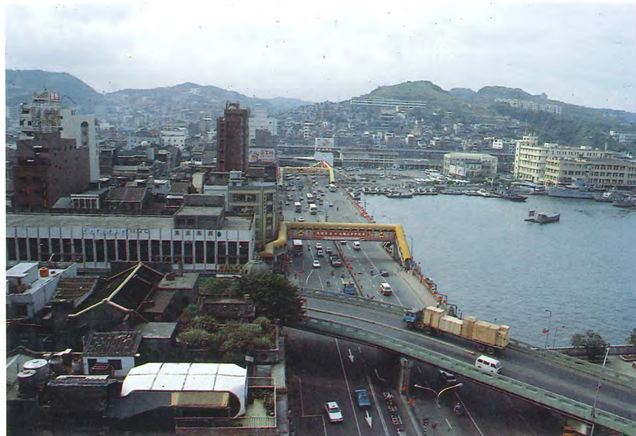
忠一路及高架道路 Chung 1 Road & Elevated High Way
