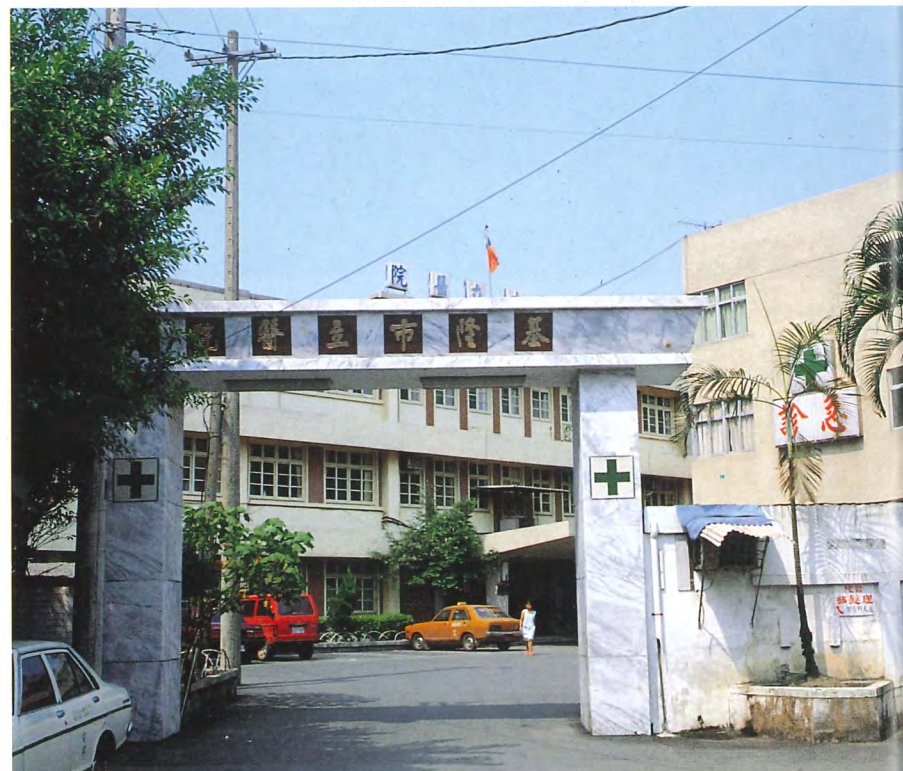
市立醫院 Municipal Keelung Hospital
