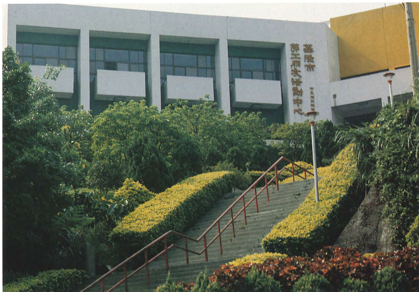
勞工活動中心 Labors' Activities Center
