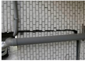
外牆柱斷裂
