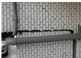
外牆柱斷裂
