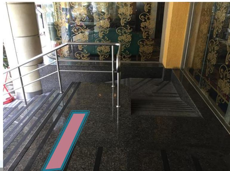
室外通路設有坡道，並於側邊設有階梯時，距梯級終端30cm處，應設置深度30~60cm、寬度 $\geq$ 130cm或該階梯寬度、顏色且質地不同之警示設施。
