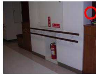
預先於牆壁設凹洞以放置滅火器
