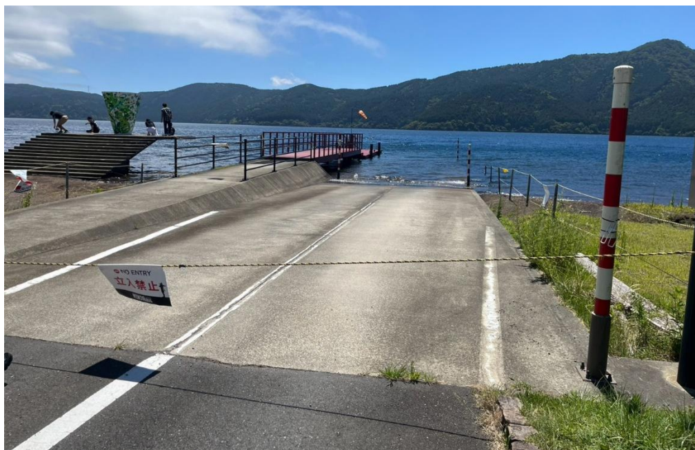
圖 58 運具下水引道現況。依據設計圖，斜坡道採兩階段坡度設計；因該區域原道路已有些微坡度，設計上將前段坡度設定約為 4.0%，並於斜坡道與水面銜接處調整為約 5.8%，以利運具順利下水。(圖片來源：本案拍攝)
