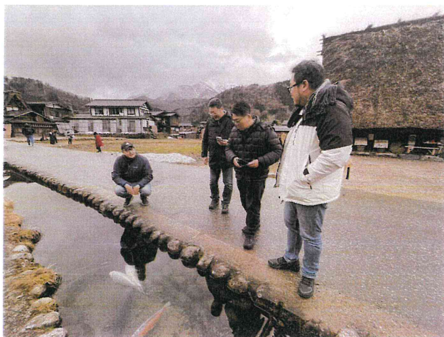
圖 22 合掌村雨水排水系統
