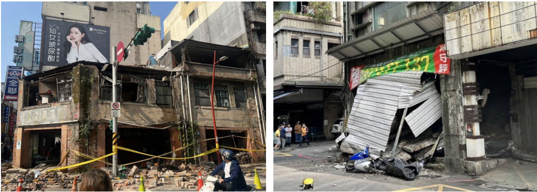
圖一、基隆市於一年內接連發生兩起老舊房屋倒塌意外
