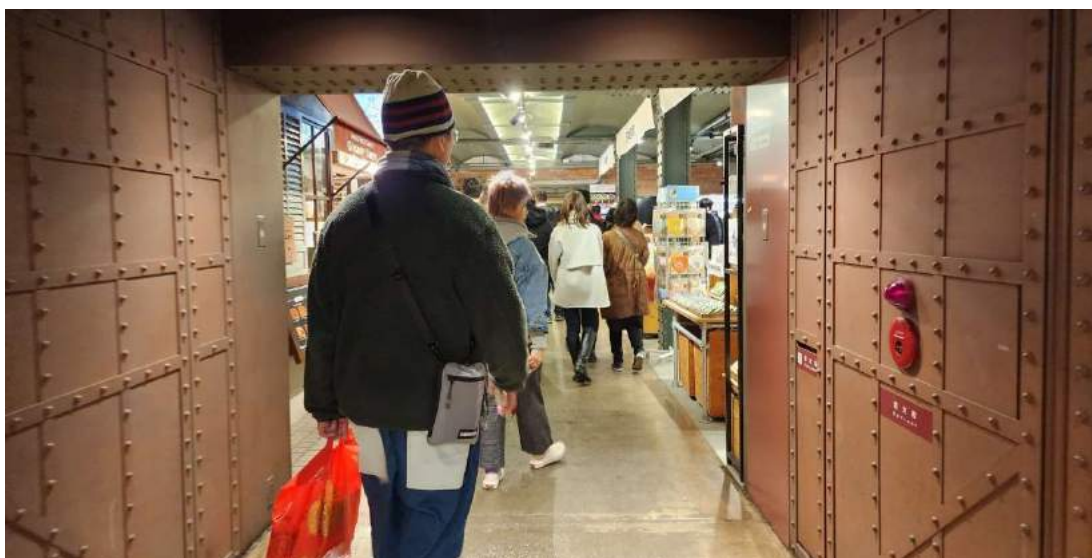
圖 60 紅磚倉庫保留防火門和掛門保設計，火災時，可將防火門關閉以防止火勢蔓延
