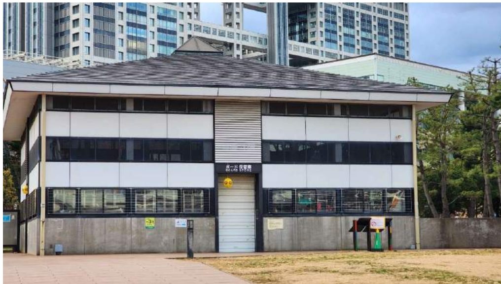
圖 77 台場海濱公園沙灘的服務中心，提供設備儲藏、租用及換洗的空間
