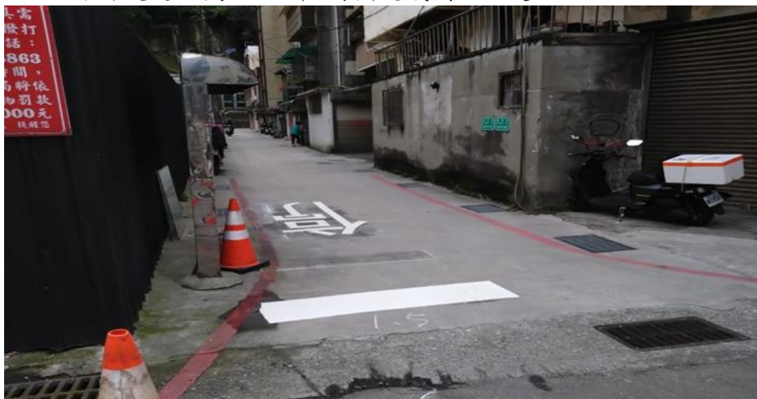
圖四：無號誌化路口停止線與停字標示完成圖
