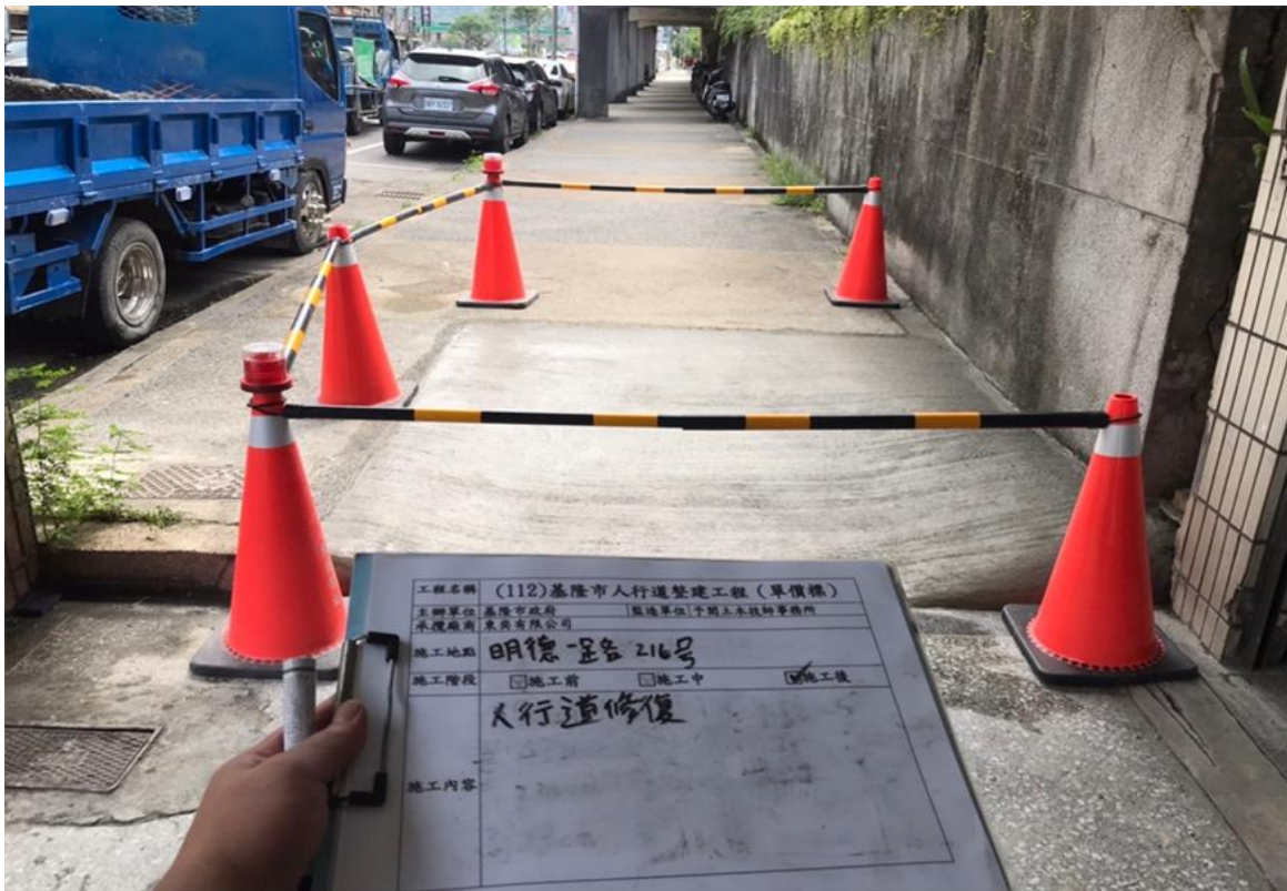
圖三：明德一路人行道整修完成圖
