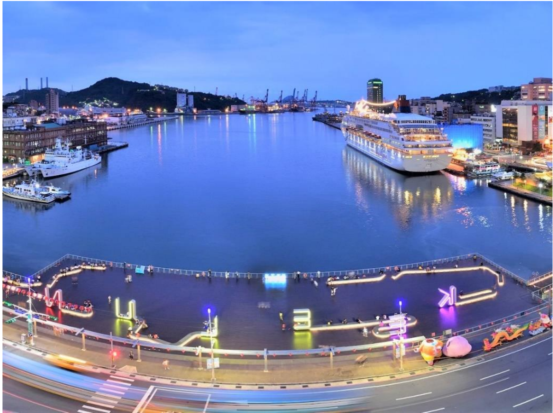
圖 150：海洋廣場空間活化改善工程
