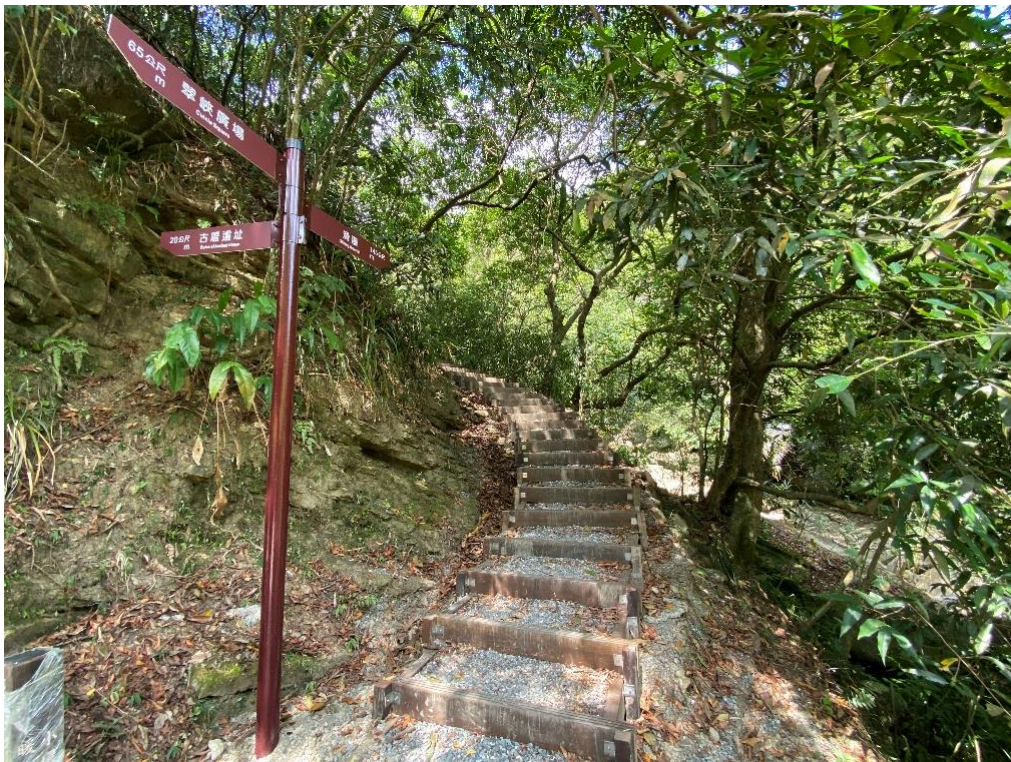
圖 161：暖東峽谷環山遊憩步道改善工程
