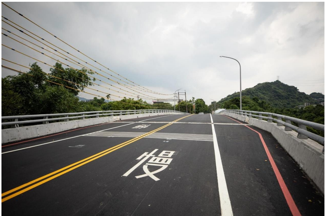
圖 105：19 號及 21 號橋改建工程
