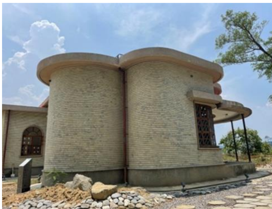
圖 58：歷史建築旭丘指揮所修復再利用工程
