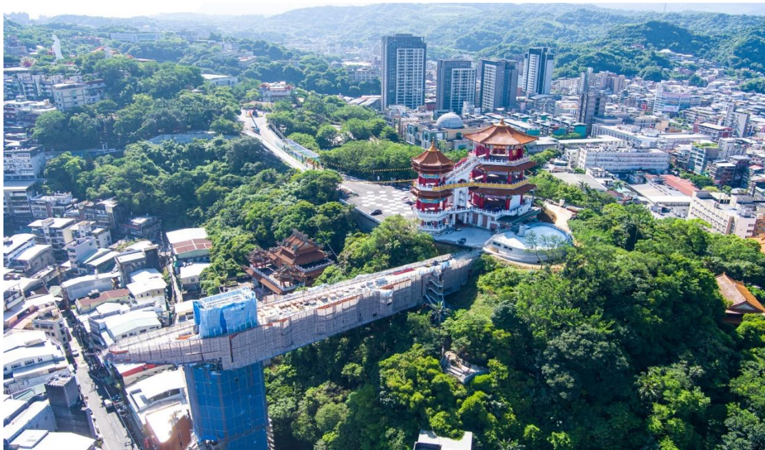
圖 48：基隆山海城串聯再造計畫工程豎梯工區
