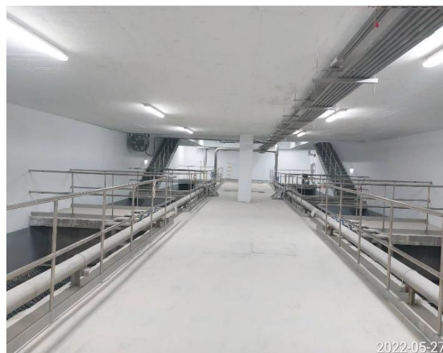
圖 165：田寮河水質改善現地處理及水環境營造工程
