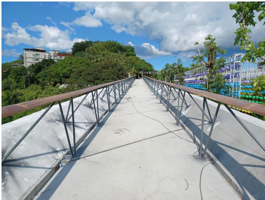
圖 50：基隆山海城串聯再造計畫工程鵲橋工區
