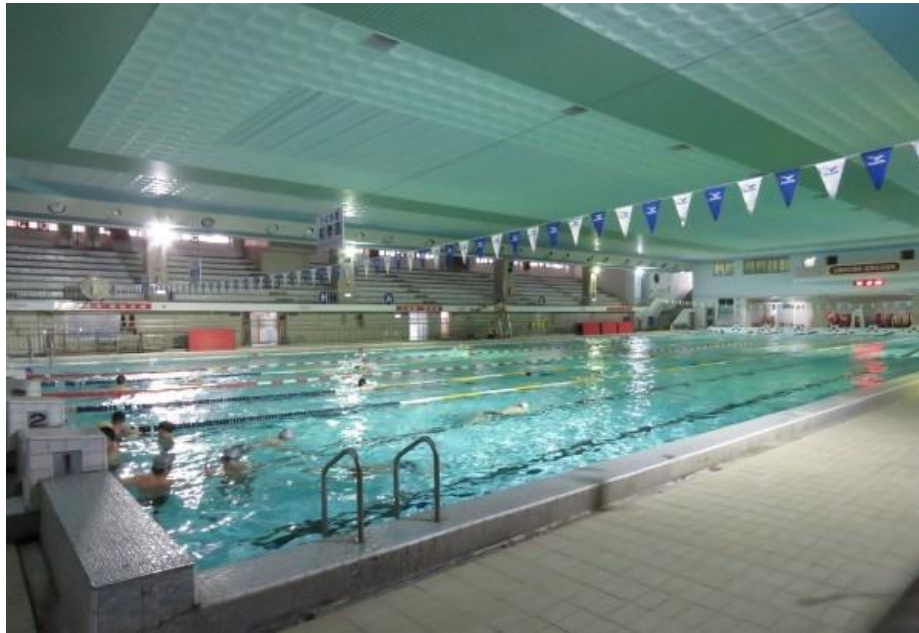
圖 115：市立體育館暨游泳池建築結構補強及設施更新整建工程
