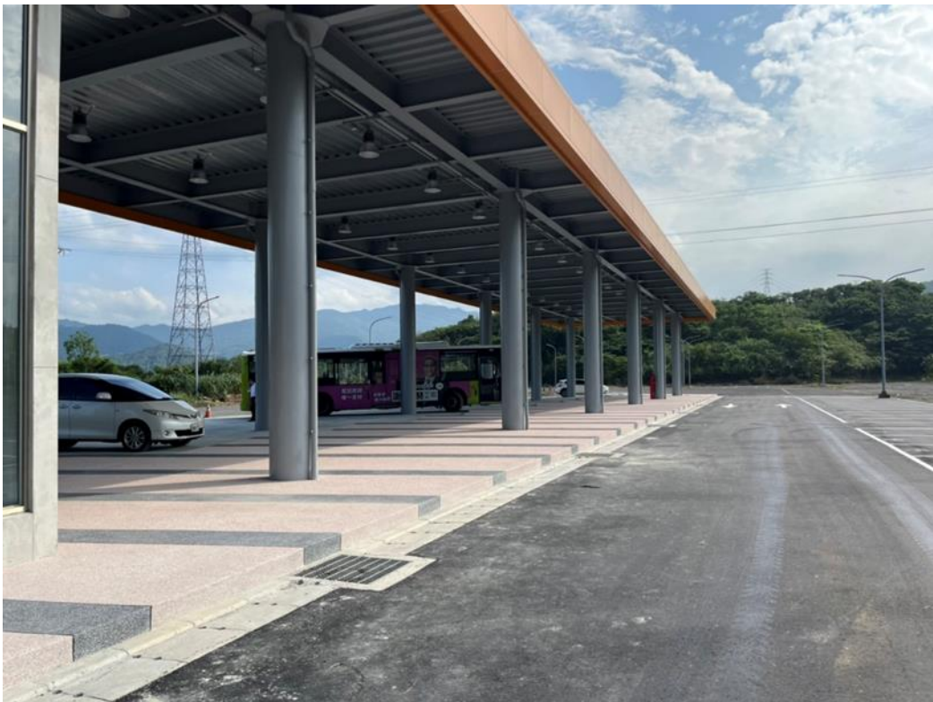
圖 88：調和街轉運站工程竣工
