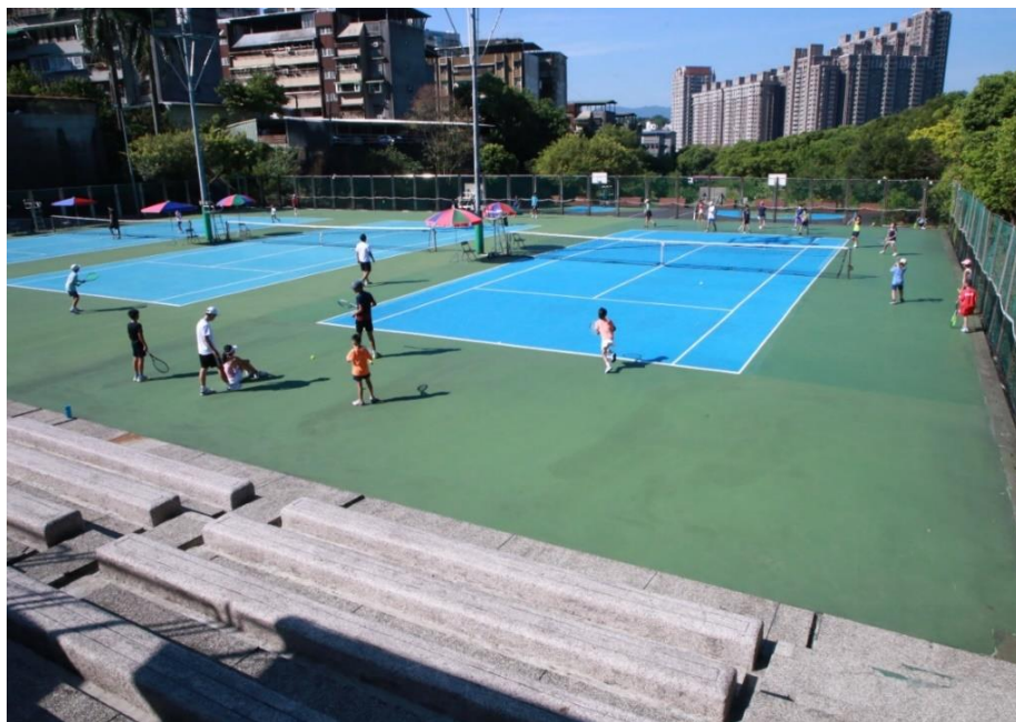
圖 116：市立網球場及附設籃球場鋪面改善工程於 111 年 7 月 24 日正式完工啟用
