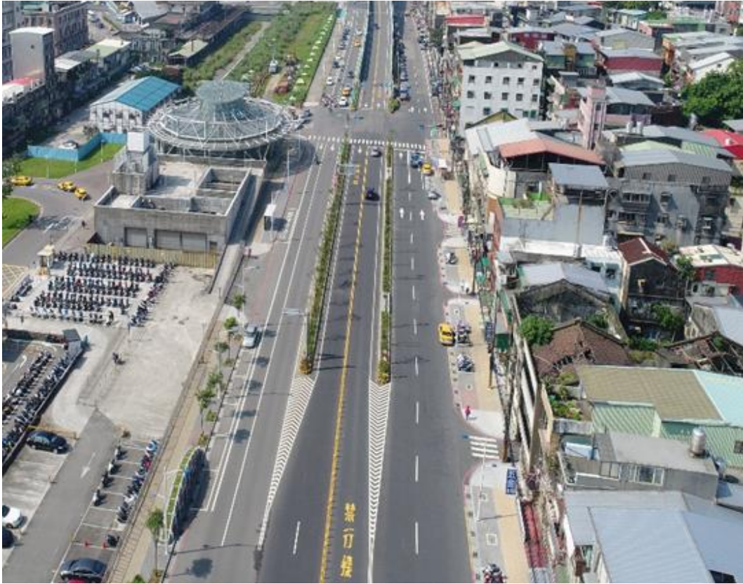
圖 30：中山一、二路拓寬工程
