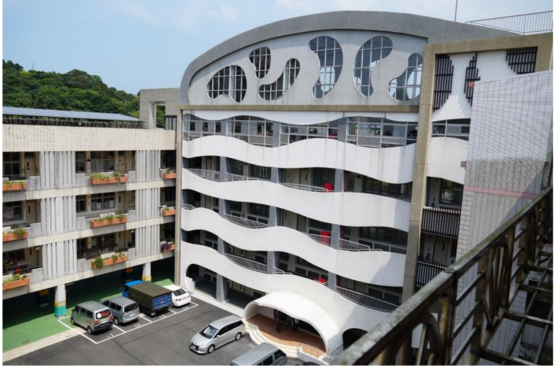
圖 122：中和國小老舊校舍整建工程於 111 年 6 月 20 日落成啟用
