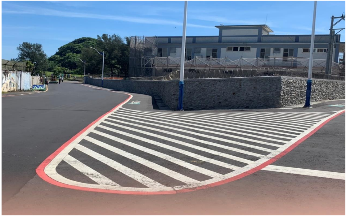
圖 186：和平營區二圍牆退縮及人行道廣場新建工程
