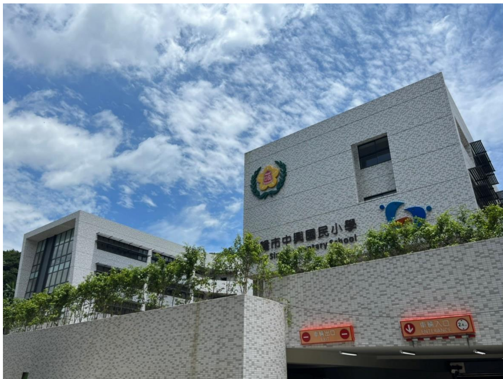
圖 120：中興國小老舊校舍改建暨停車場新建工程完工
