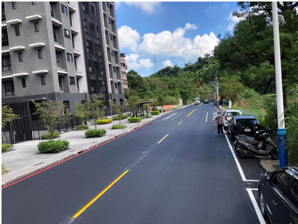
圖 103：東勢街路廊改善工程
