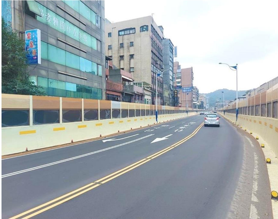
圖 106：中正高架橋護欄及隔音牆改善工程
