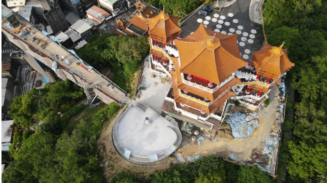
圖 49：基隆山海城串聯再造計畫工程主普壇工區
