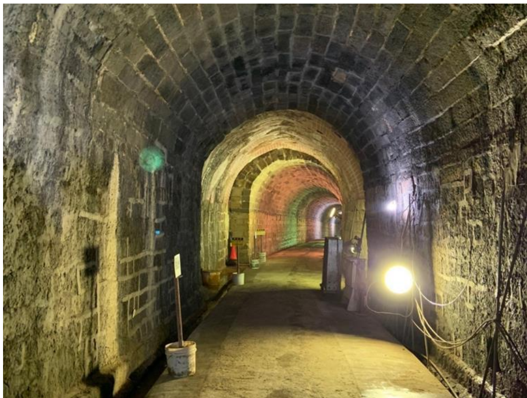
圖 70：市定古蹟劉銘傳隧道修復工程
