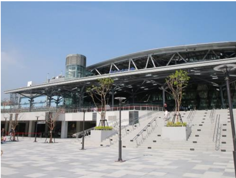
圖 32：基隆火車站南站廣場工程
