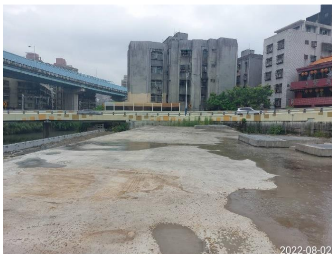
圖 164：旭川河水質改善現地處理工程
