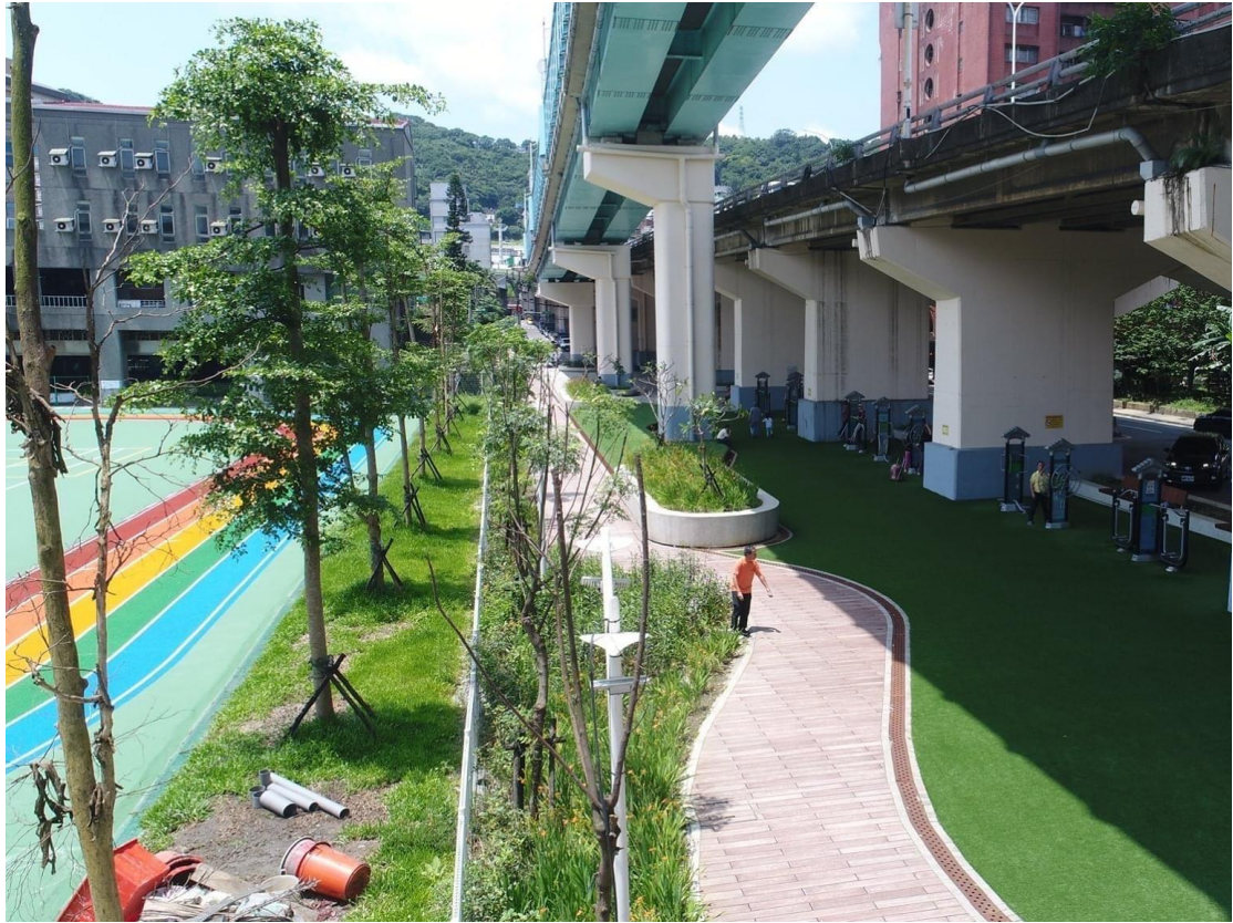
圖 153：成功國小西側 29 號橋下環境美化與空間整建工程
