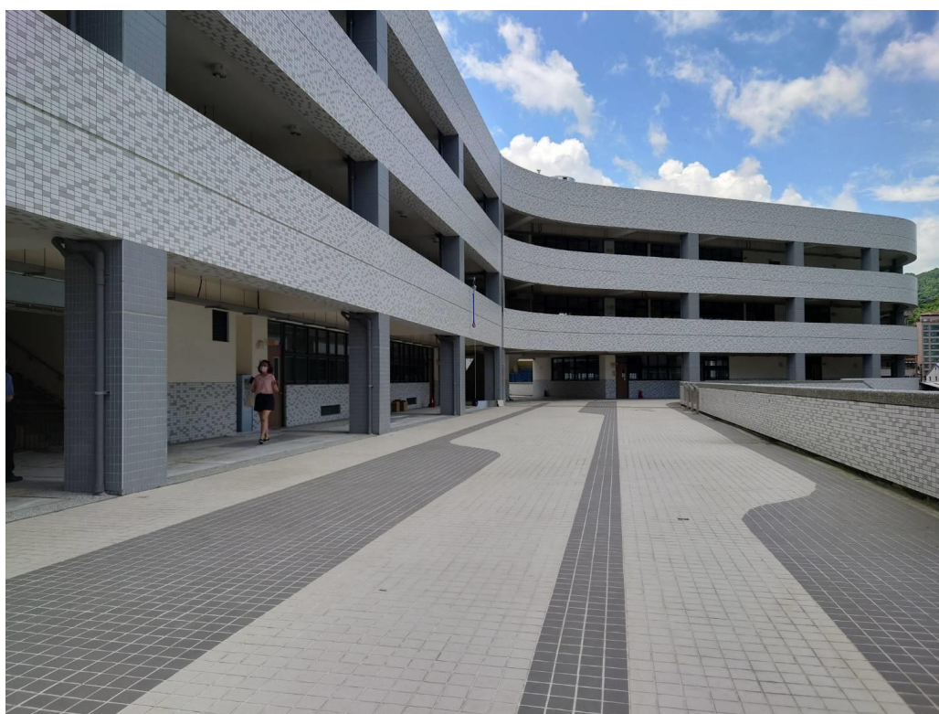
圖 121：中興國小老舊校舍改建暨停車場新建工程完工
