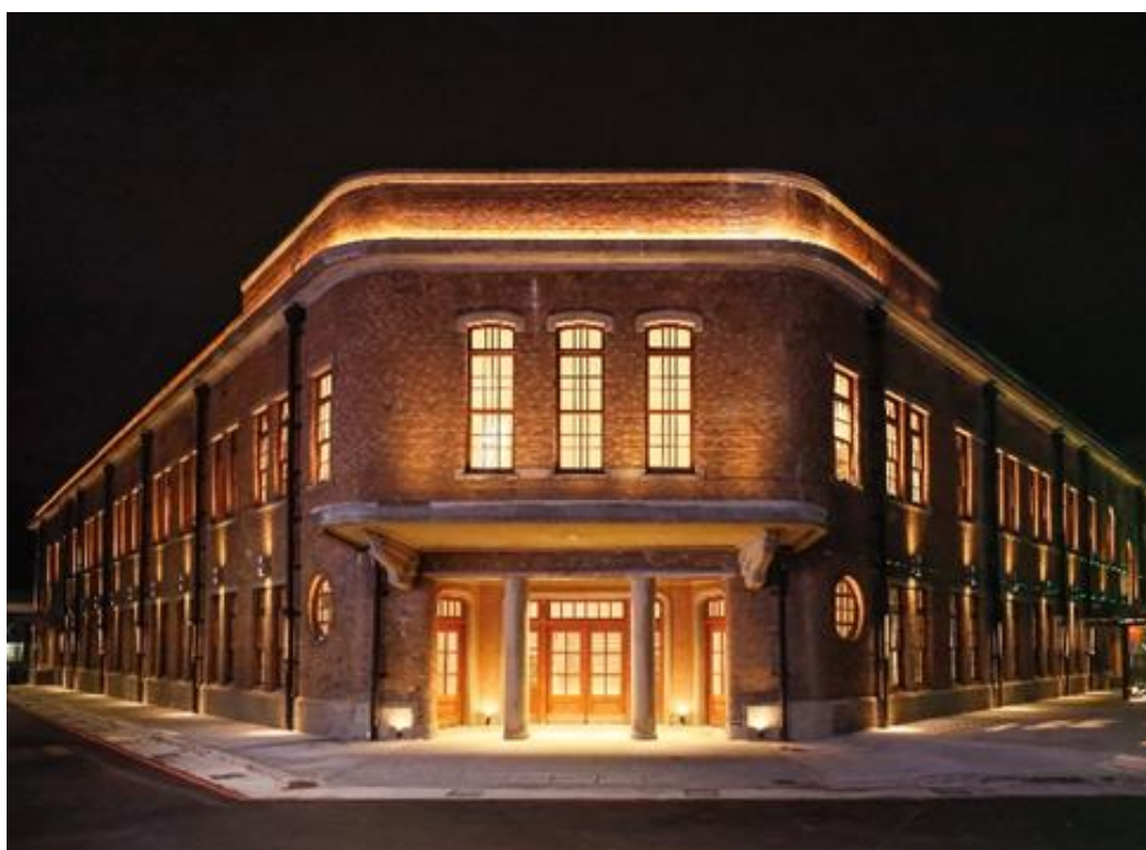
圖 172：歷史建築漁會正濱大樓修復再利用工程
