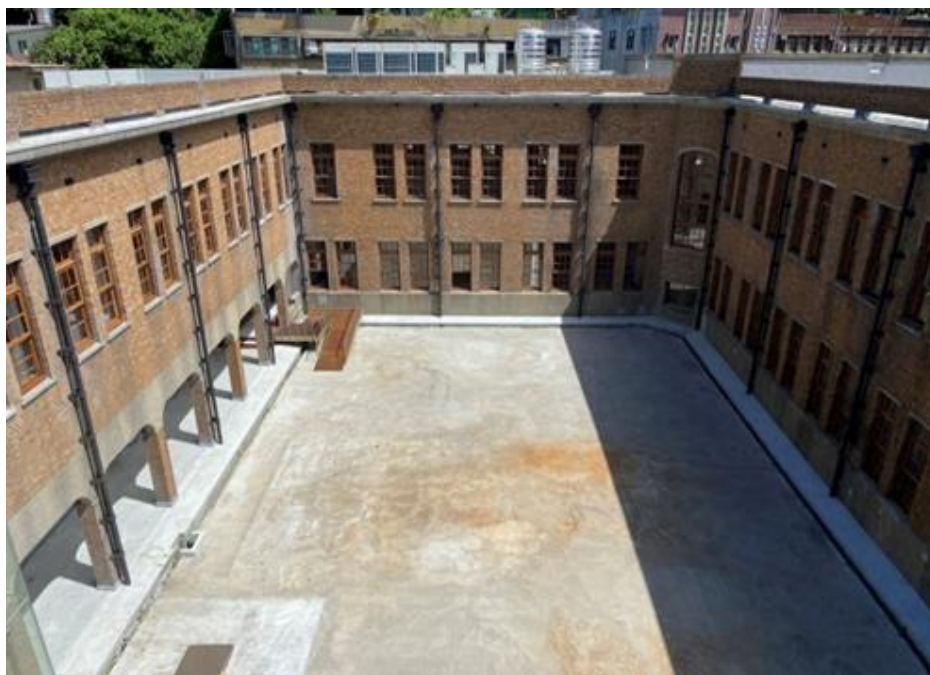
圖 62：歷史建築漁會正濱大樓修復再利用工程
