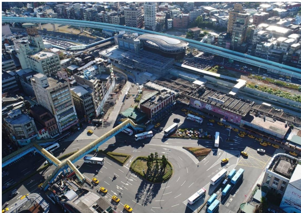
圖 33：未拆除前的舊國光客運站及忠一路天橋
