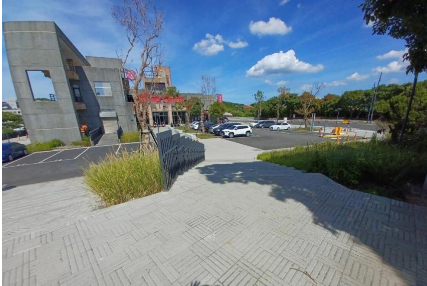
圖 54：希望之丘山城社區通廊系統第二階段工程
