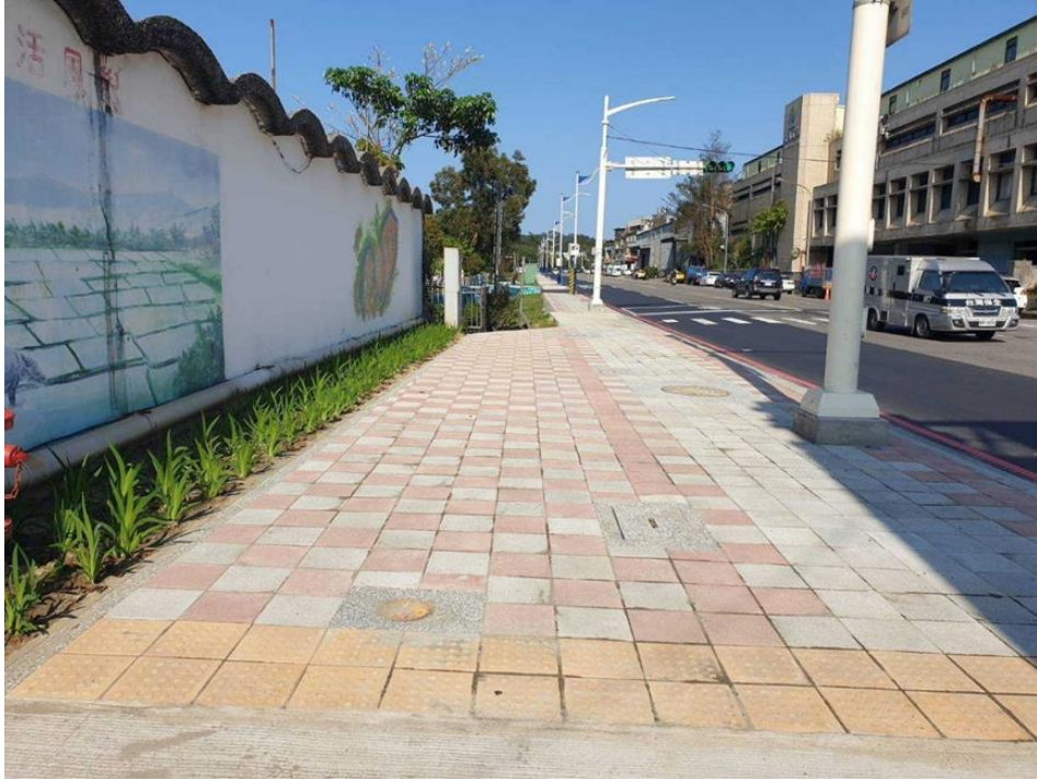
圖 100：工建西路暨俊賢路沿線人行道改善工程
