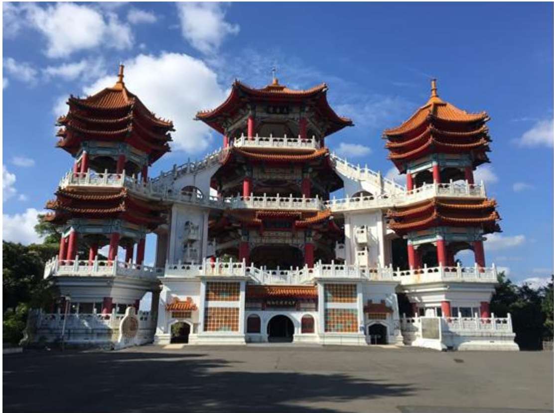
圖 146：主普壇耐震補強暨修復工程於 110 年 1 月完工
