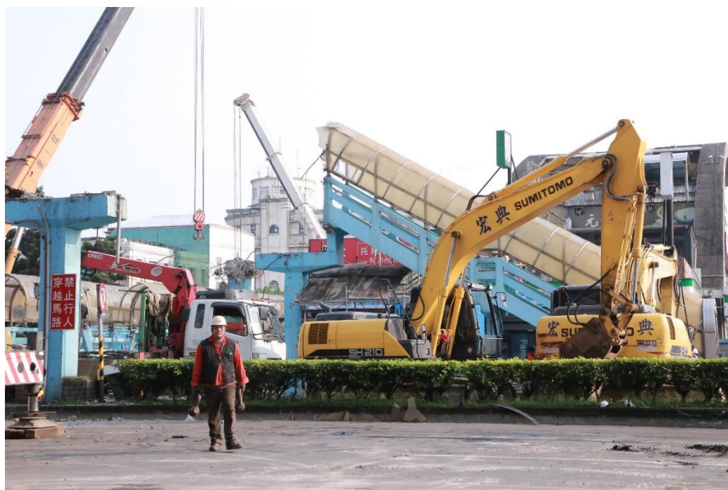
圖 34：忠一路天橋拆除工程
