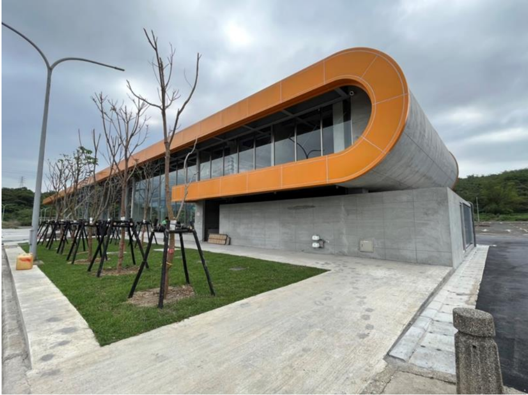
圖 87：調和街轉運站工程竣工
