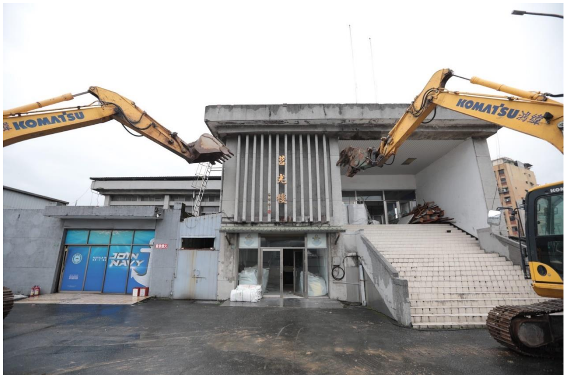
圖 47：威海營區舊營舍開始第一階段拆除工程 111 年 1 月動工
