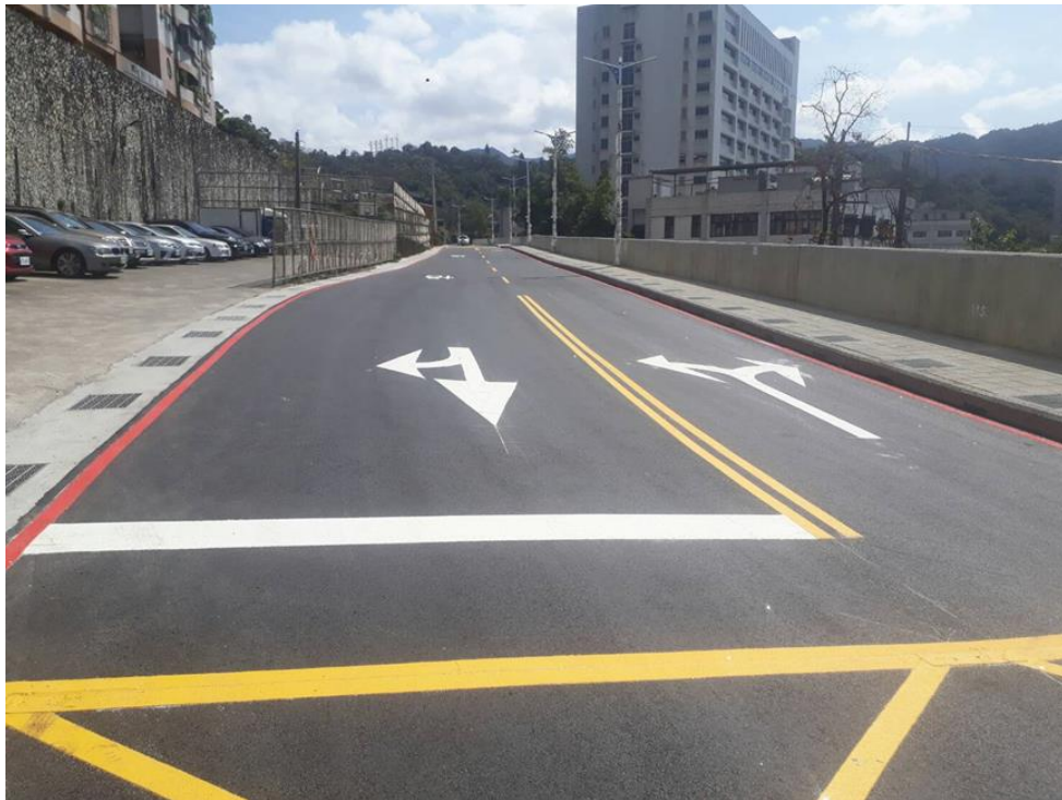
圖 98：六堵工東街道路拓寬工程
