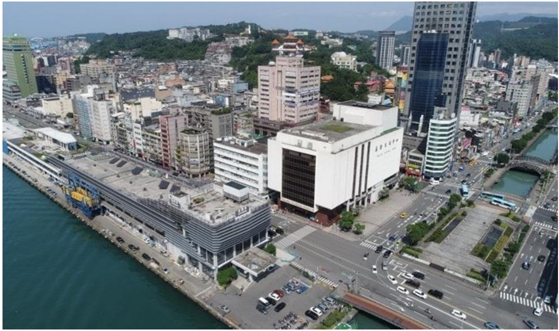
圖 44：東岸郵輪廣場工程施工前
