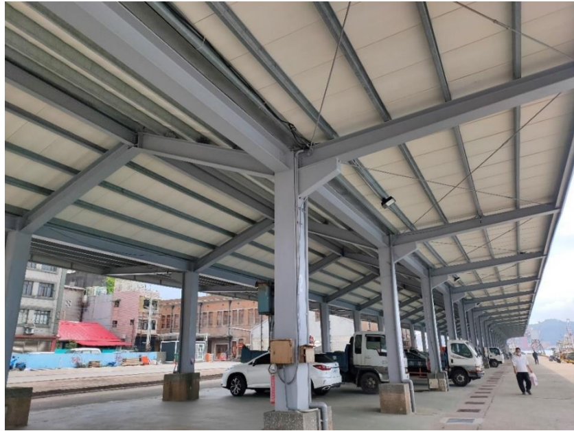
圖 51：正濱漁港漁獲拍賣場頂棚損壞修復工程
