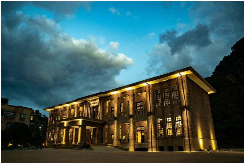
圖 49：基隆要塞司令部修復再利用工程已於 110 年 12 月完工
