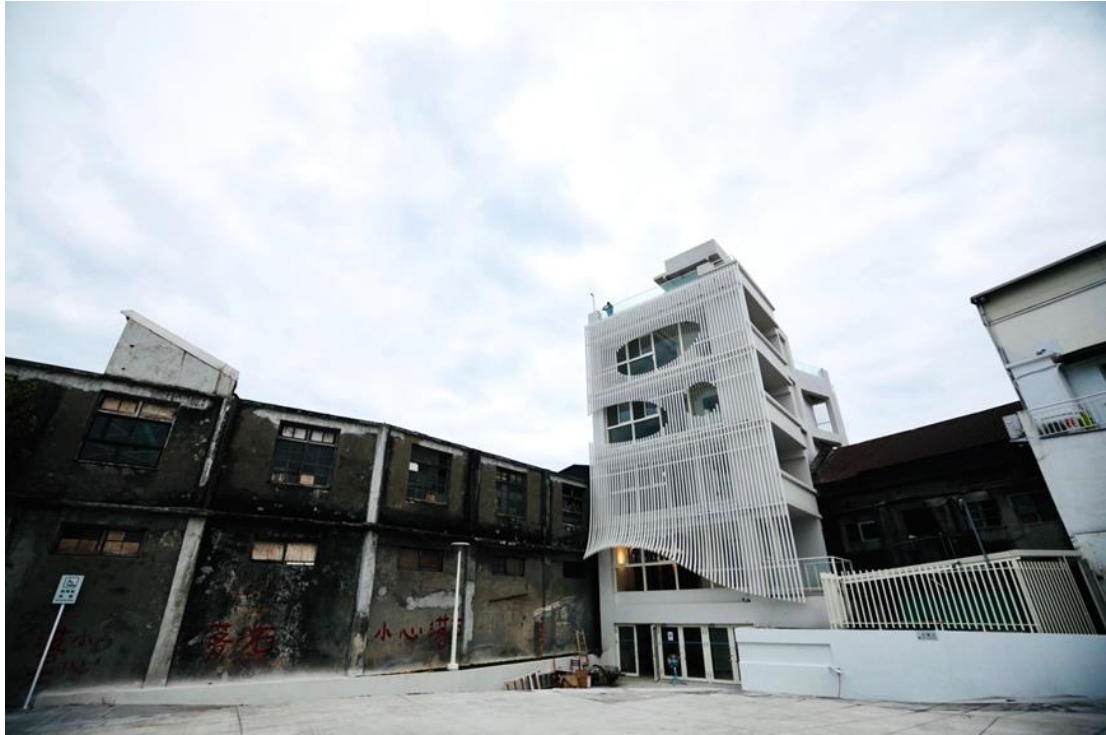
圖 45：正濱派出所活化再利用暨周邊環境改善工程
