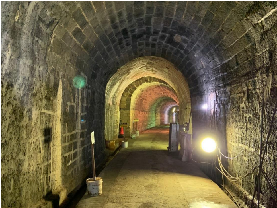
圖 57：市定古蹟劉銘傳隧道修復工程於 110 年 12 月完工
