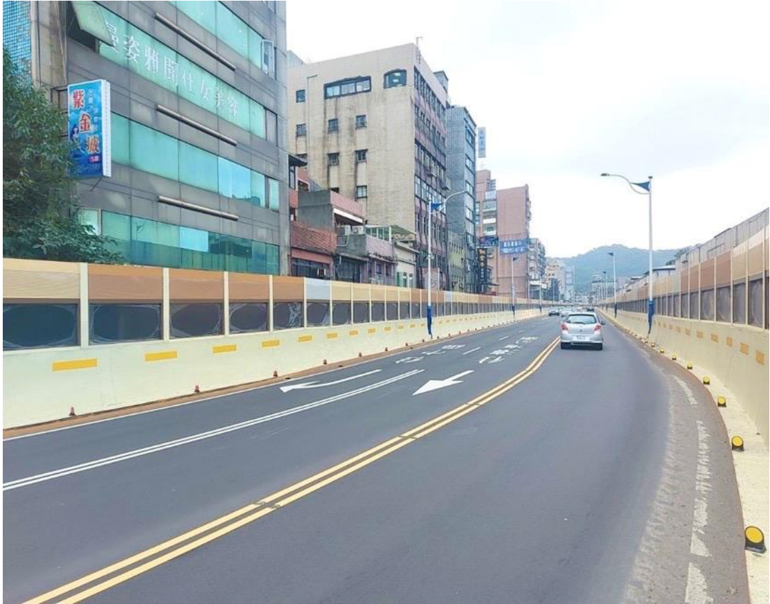
圖 24：中正高架橋護欄及隔音牆改善工程
