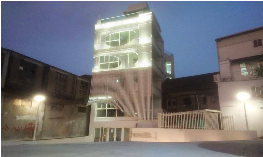
圖 46：正濱派出所活化再利用暨周邊環境改善工程
