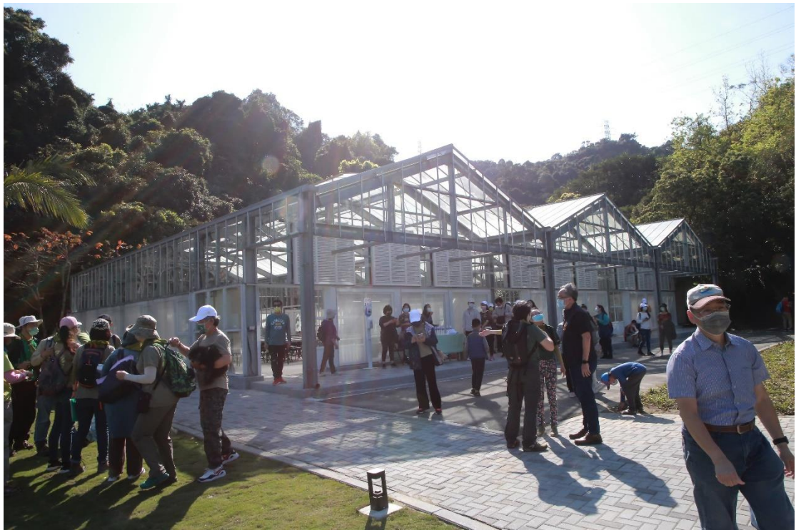
圖 36：暖東苗圃生態池及園區景觀改善工程-溫室
