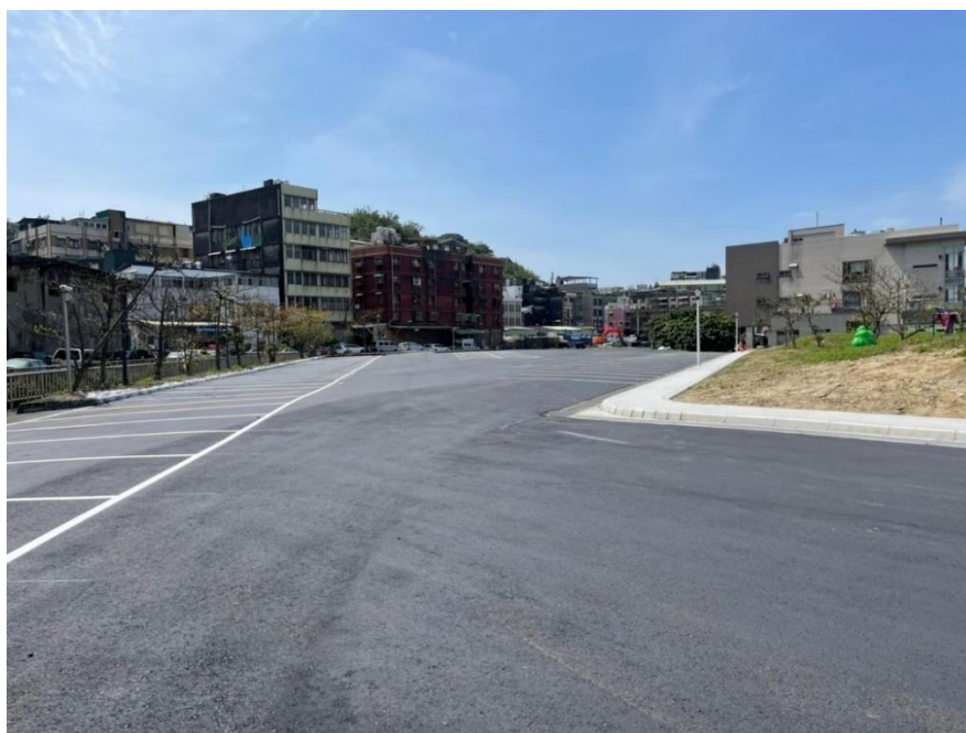
圖 53：正濱漁港地磅站及停車場周邊鋪面改善工程
