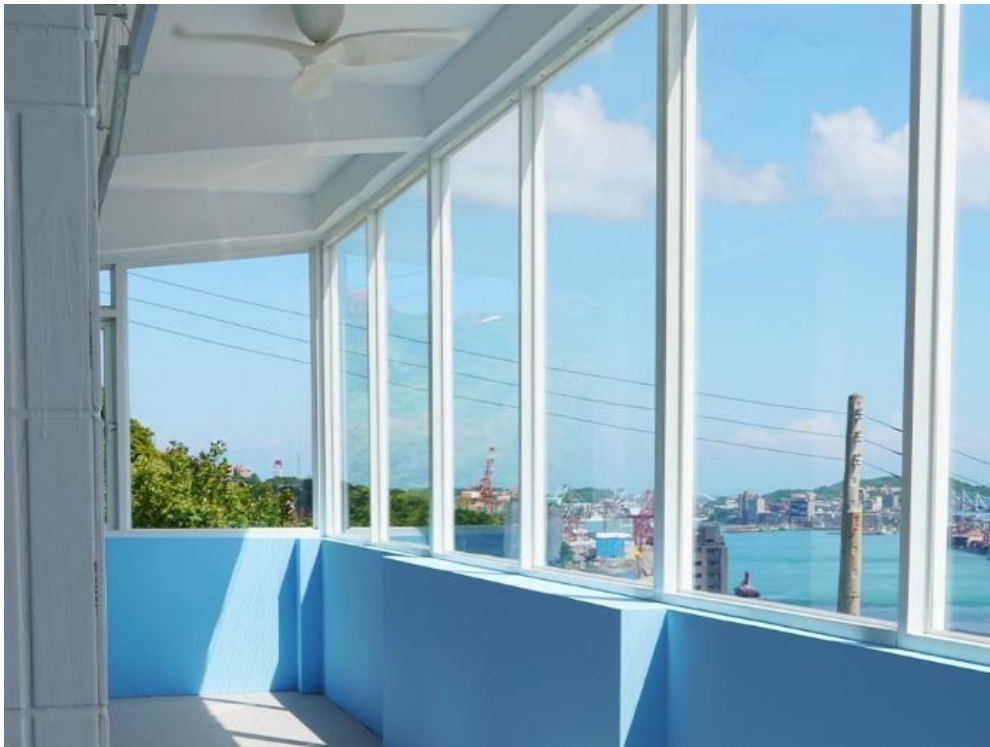
圖 29：太平國小校舍空間環境暨周邊環境改善工程
