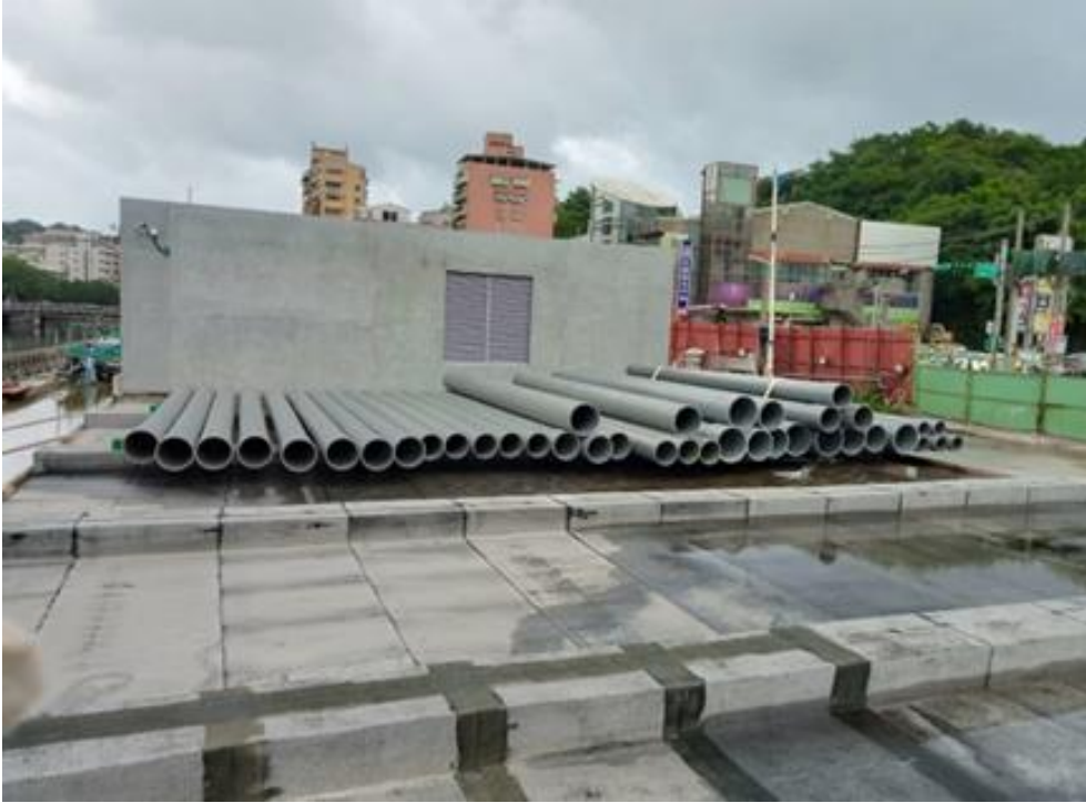
圖 45：田寮河水環境改善工程計畫第一期施工情形
