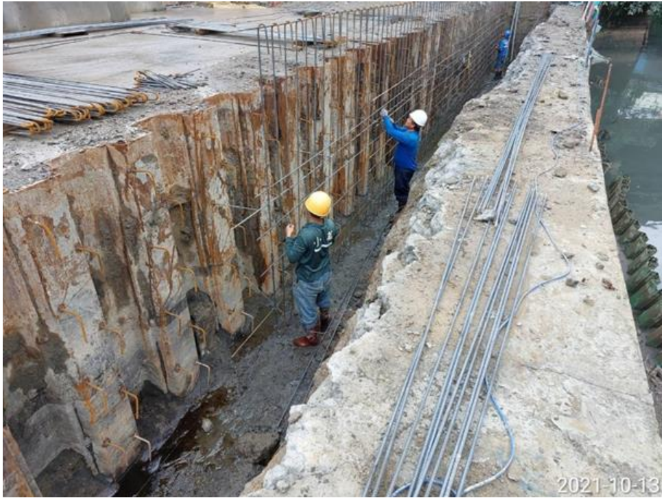
圖 47：旭川河水質改善現地處理工程第一期
