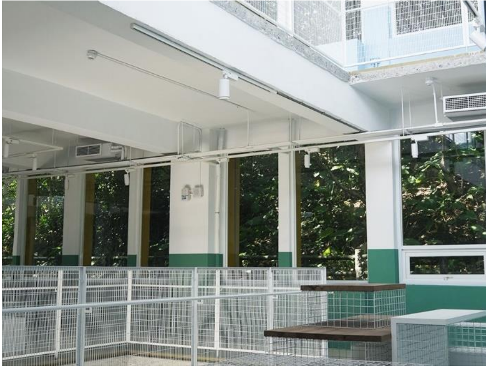
圖 28：太平國小校舍空間環境暨周邊環境改善工程
