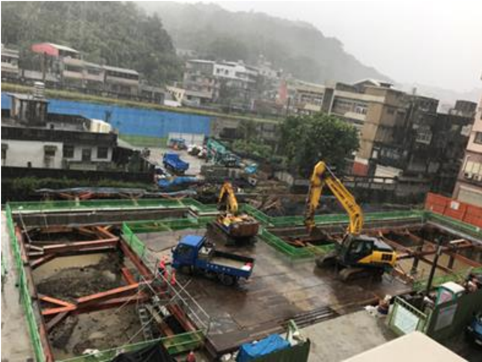
圖 49：南榮河水質提升現地處理及沿岸水環境營造工程施工情形
