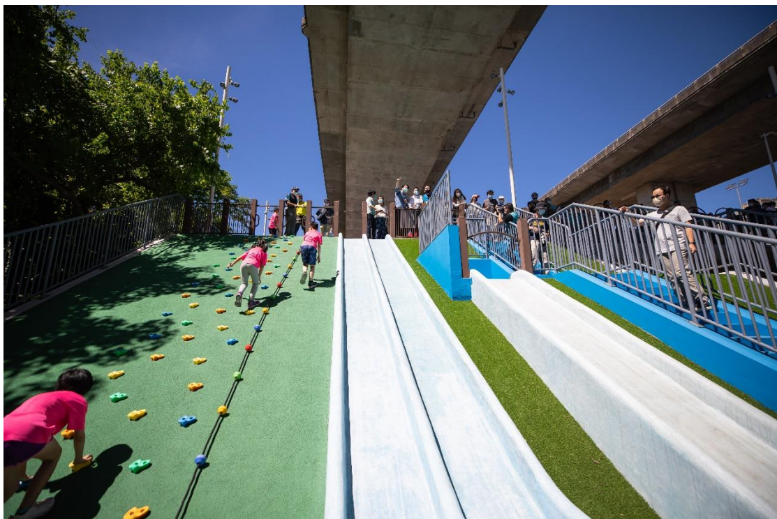
圖 42：基隆市大武崙森林運動公園第一期工程完工啟用
