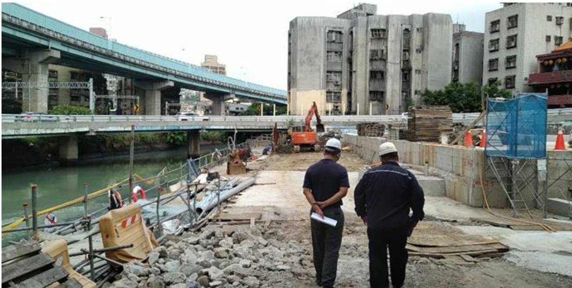
圖 48：旭川河沉砂池二期水環境改善工程
