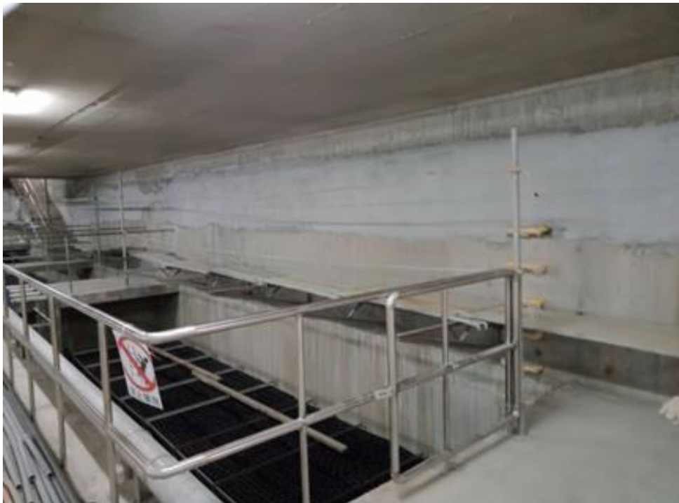
圖 46：田寮河水環境改善工程計畫第一期施工情形
