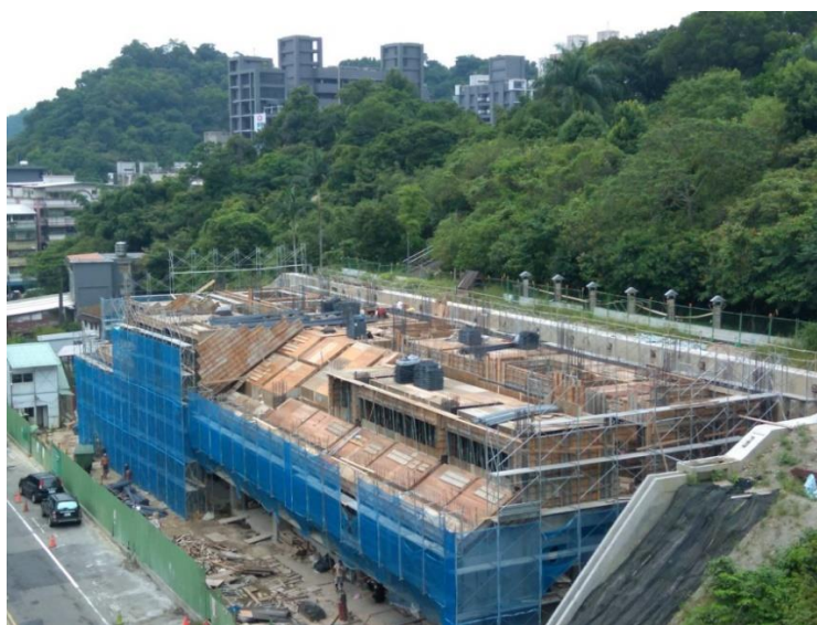
圖 31：暖暖消防分隊施工照片
