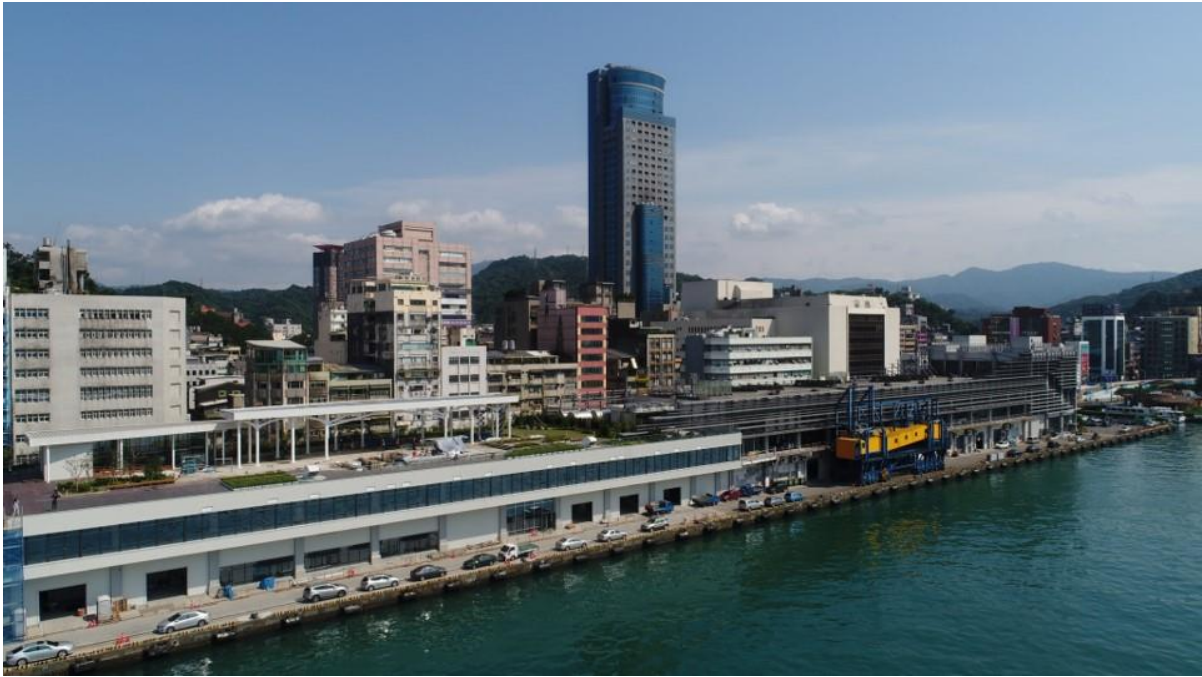
圖 43：基隆港東 3、東 4 碼頭旅運設施新建施工照
