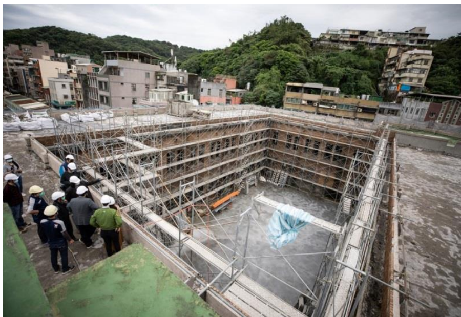
圖 29：正濱漁會大樓修復工程
