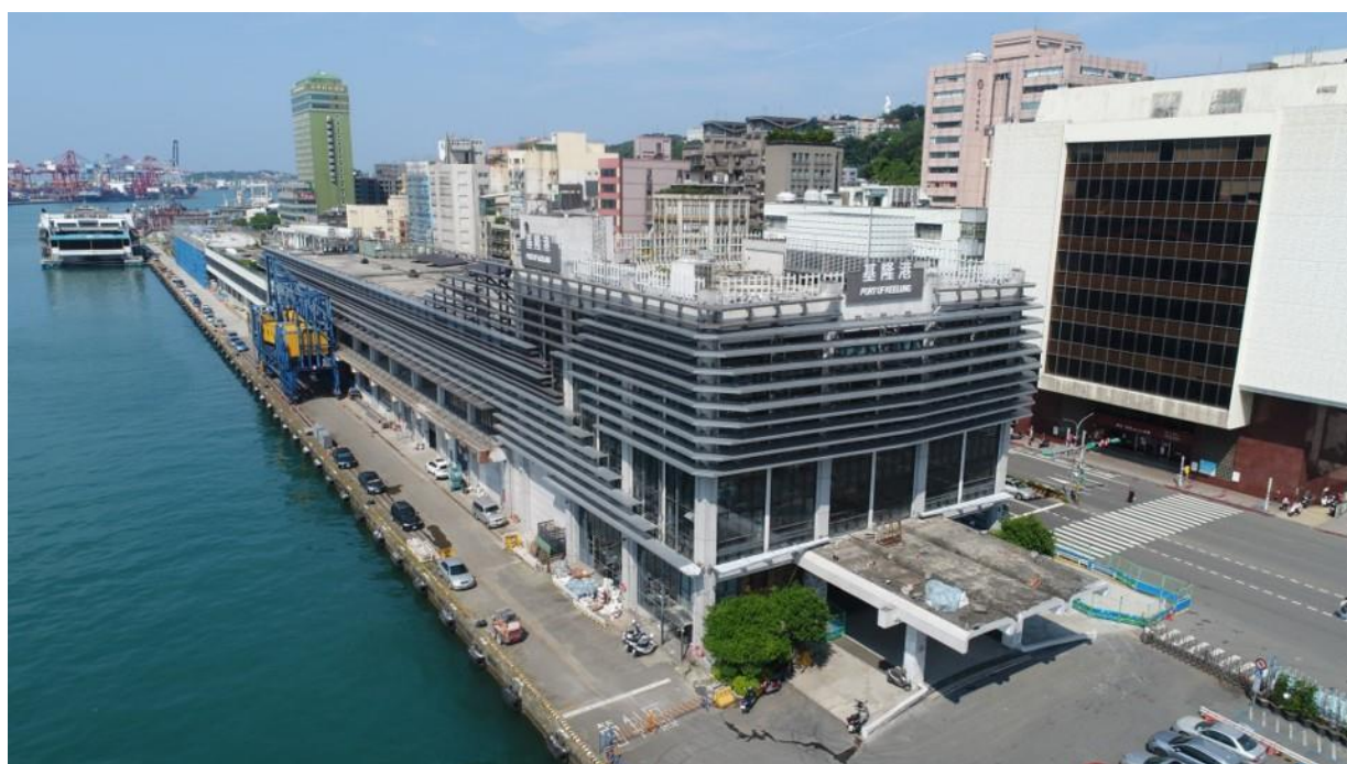
圖 42：基隆港東 3、東 4 碼頭旅運設施新建施工照
