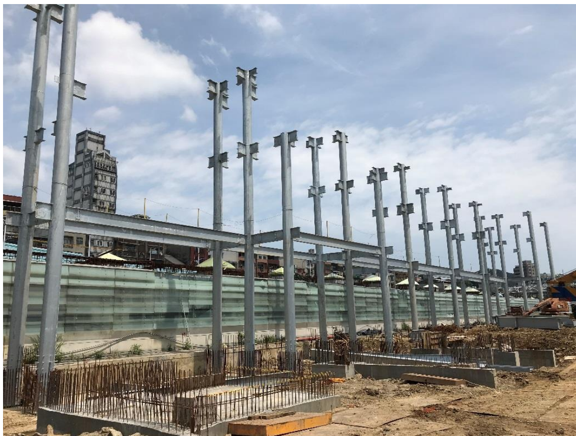
圖 39：基隆城際轉運站鋼柱及鋼梁組立
