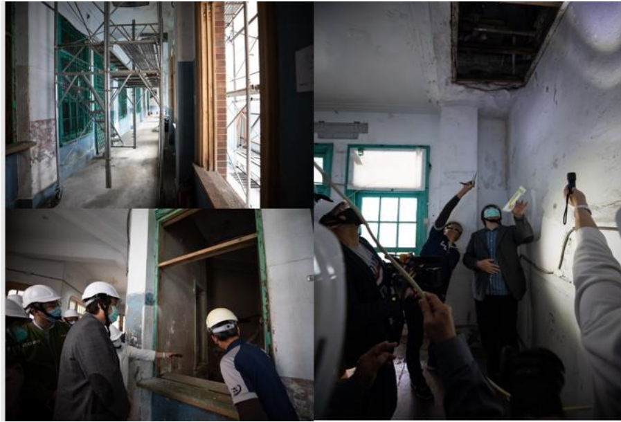
圖 30：正濱漁會大樓修復工程
