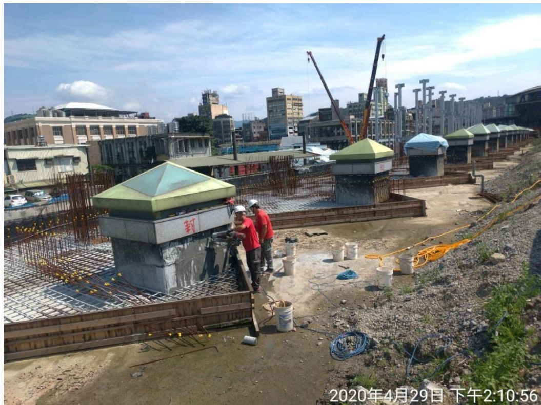
圖 40：新建轉運站 2 樓通風井拆除
