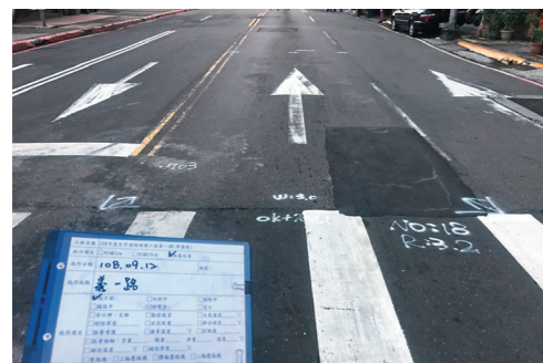
↑ 義一路刨鋪前，可明顯看到路面凹凸不平。
