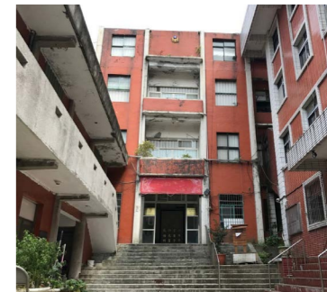
↓ 目前已閒置的舊分局，未來將成為起重機電梯的底座。
