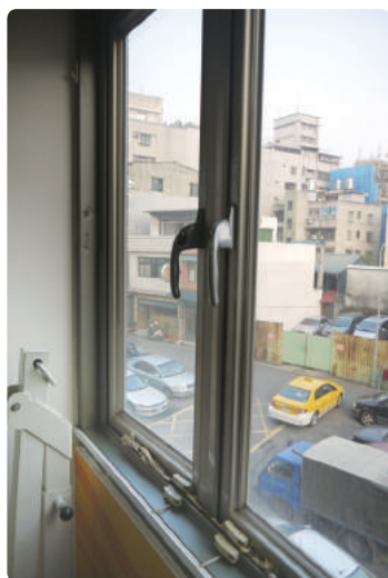
▲ 可供緊急逃生之窗戶
