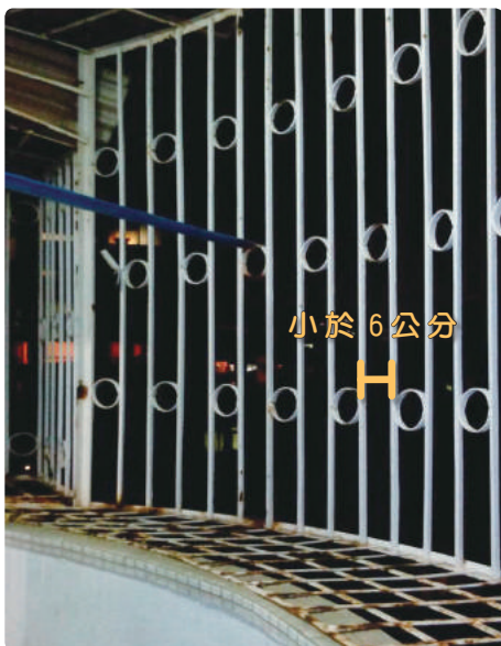
▲ 裝設鐵窗，且間隔（縫）小於 6 公分
