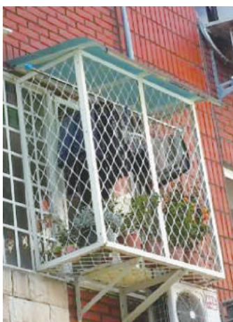
▲ 窗戶整體裝設護欄，如：鐵窗
