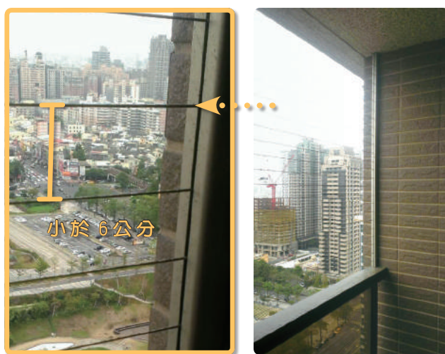
▲ 防墜圍籬、柵欄，間隔（縫）小於 6 公分
