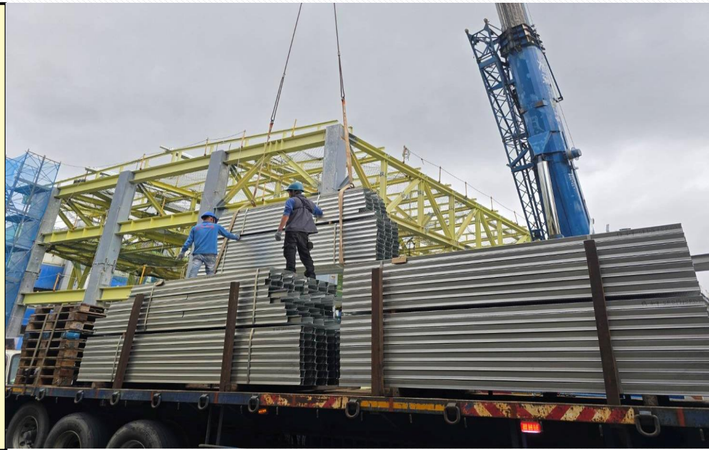
鋼構材料進場
