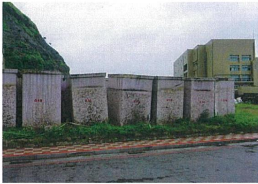
支走道浮箱堆置陸地
