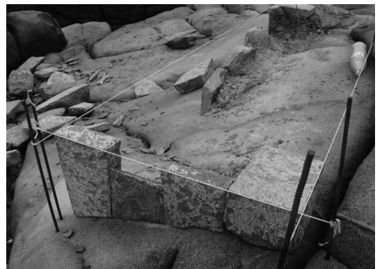
Punta Pite 海岸岩徑 - 現場施工狀況
