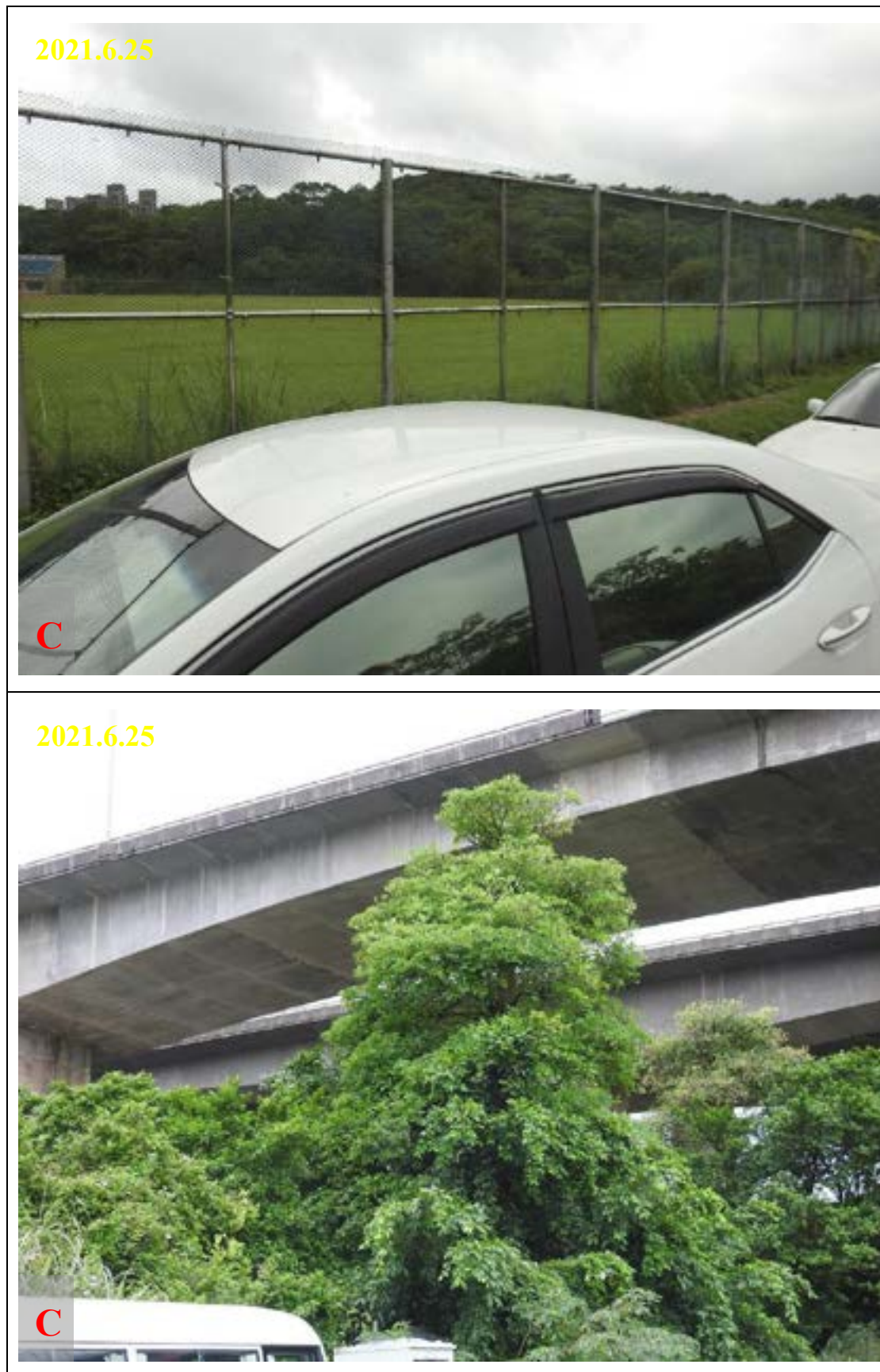
圖 3.6.2-2 大武崙溪中期治理計畫工程現勘紀錄(6 月 25 日)
