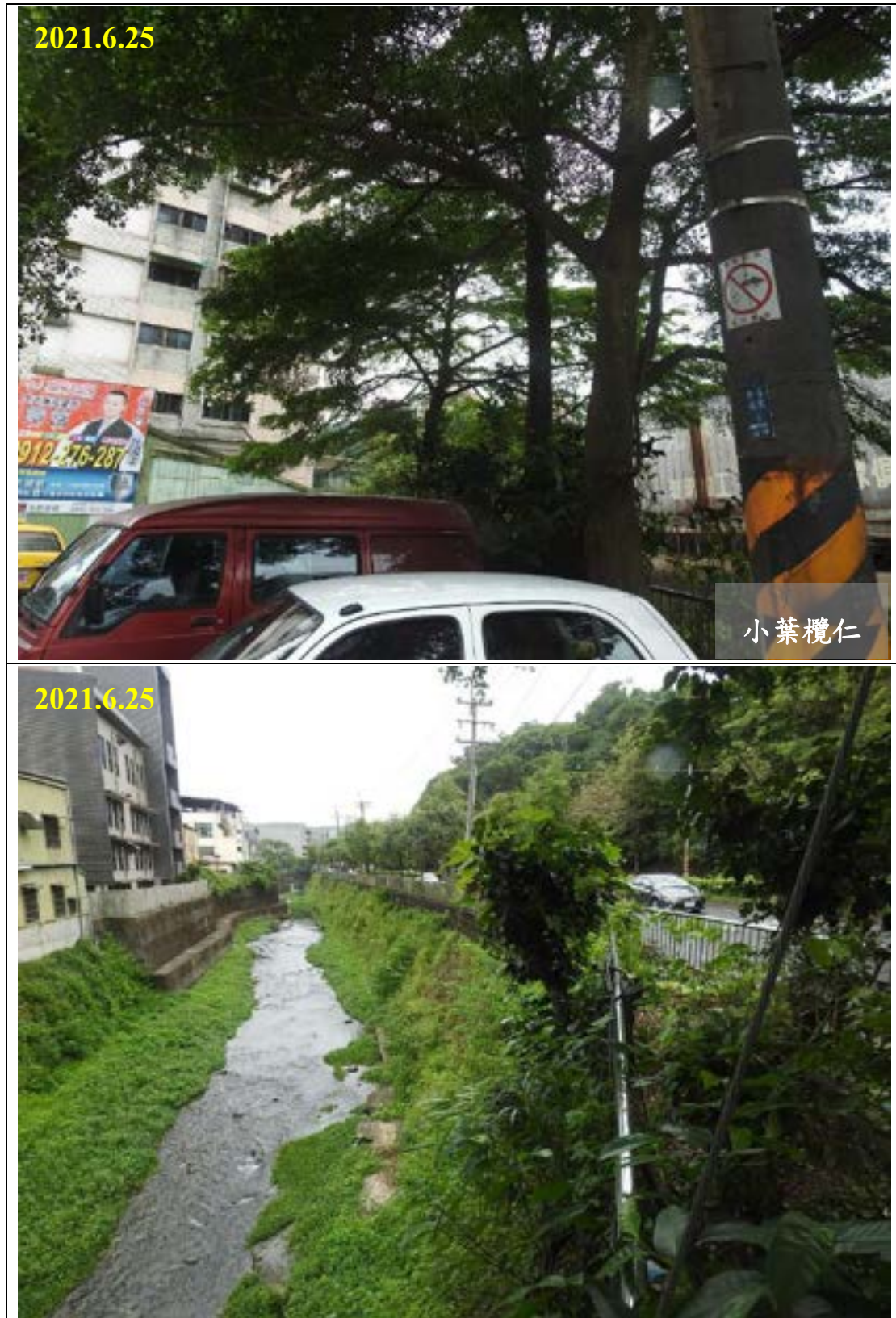
圖 3.5.3-2 大武崙溪分洪道(入口)工程現勘紀錄(6 月 25 日)
