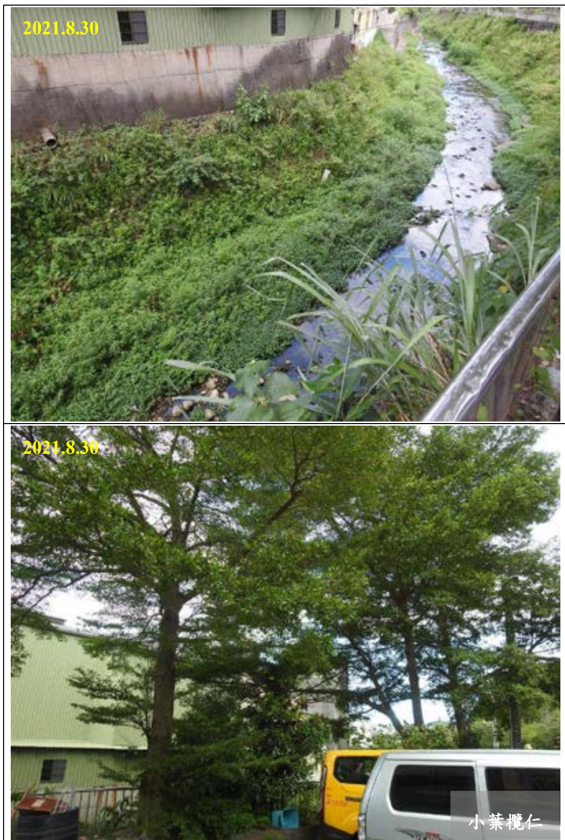
圖 3.5.3-4 大武崙溪分洪道(入口)工程現勘紀錄(8 月 30 日)
