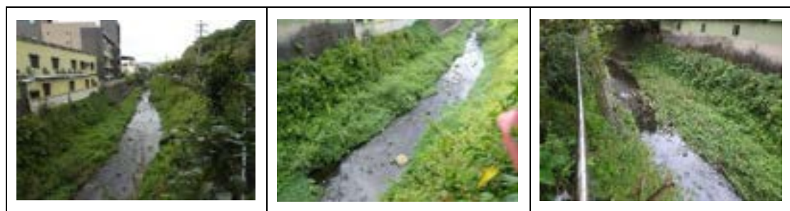
圖 2.2-3 大武崙溪分洪道(入口處)工程河道現況
