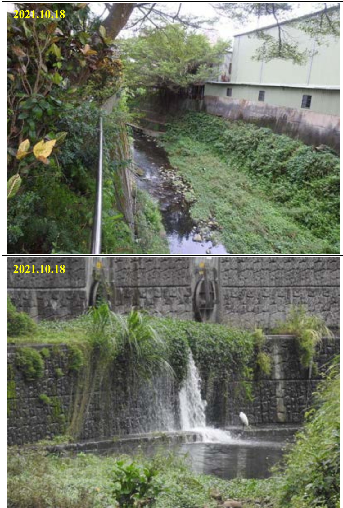
圖 3.5.3-6 大武崙溪分洪道(入口)工程現勘紀錄(10 月 18 日)
