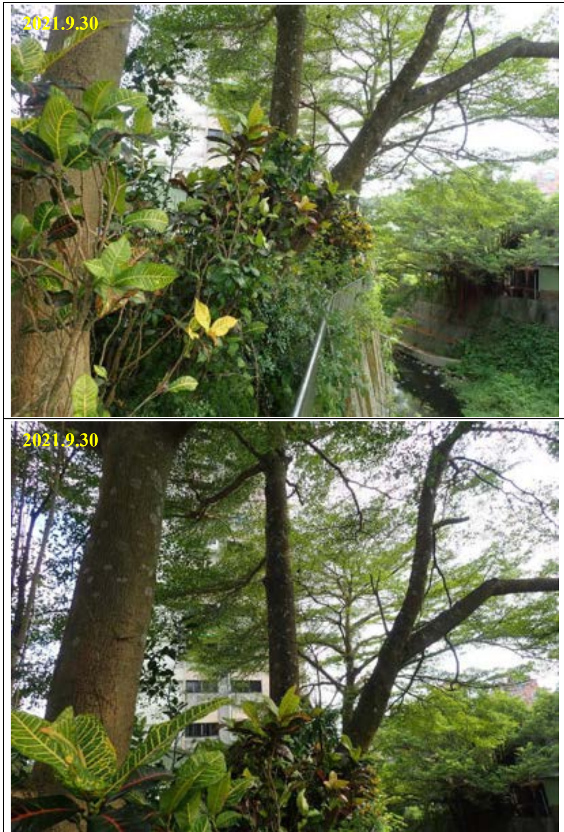
圖 3.5.3-5 大武崙溪分洪道(入口)工程現勘紀錄(9 月 30 日)
