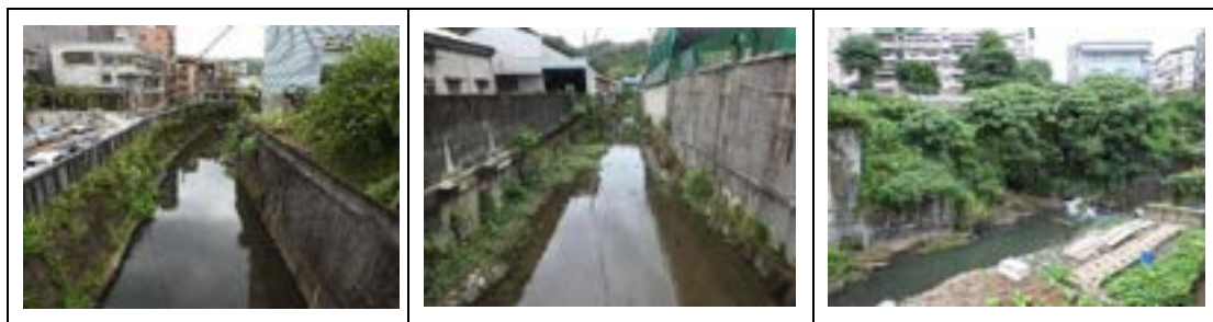
圖 2.2-1 順興橋至民樂橋段改善工程上游段河道現況
