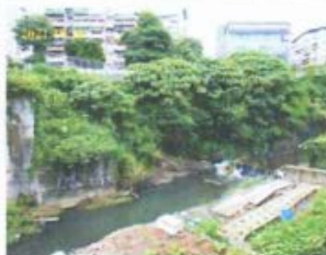
B-3-1邊坡情形
