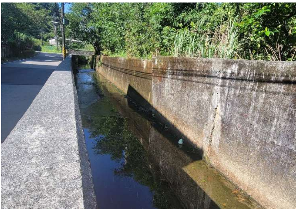
圖 6.1.7 石厝坑溪治理工程下游段影像紀錄
