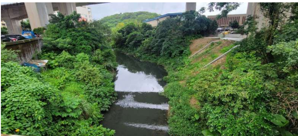
圖 4.1.2 順興橋至民樂橋段改善工程下游段河道現況
