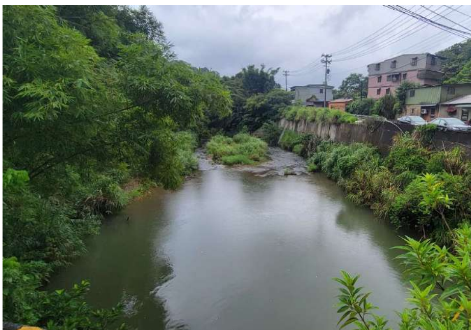
圖 6.1.8 友蚋溪友諒橋改建及護岸工程下游段影像紀錄
