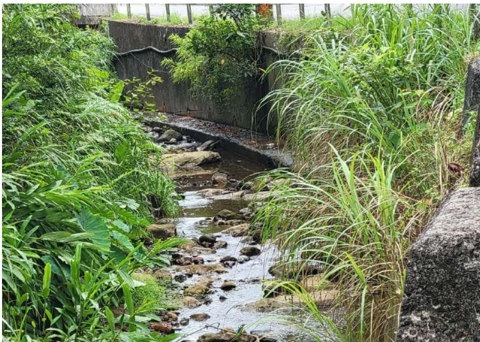
圖 6.1.6 石厝坑溪治理工程上游段影像紀錄
