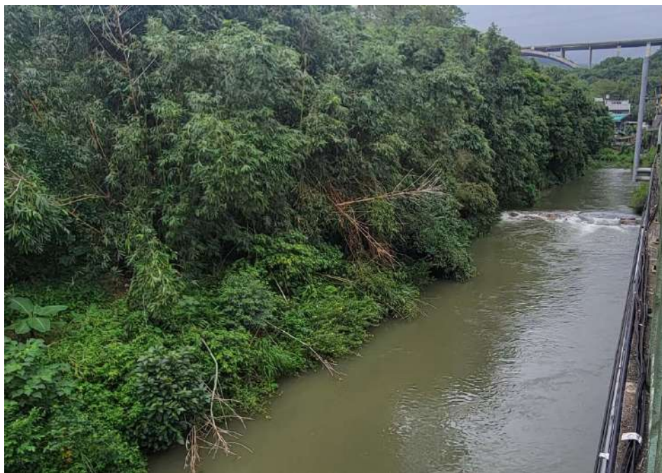
圖 6.1.4 瑪陵坑溪復興橋改建及護岸工程周邊影像紀錄
