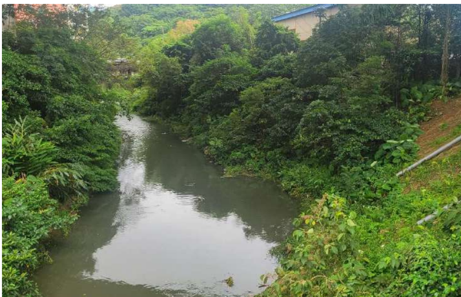
圖 6.1.3 順興橋至民樂橋段改善工程民樂橋段影像紀錄
