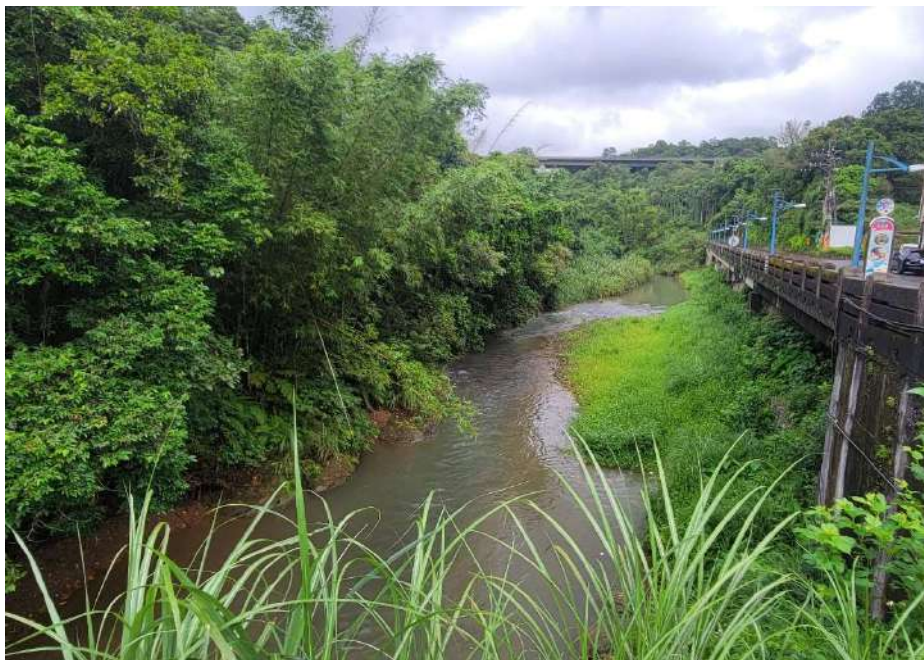
圖 6.1.8 友蚋溪友諒橋改建及護岸工程上游段影像紀錄
