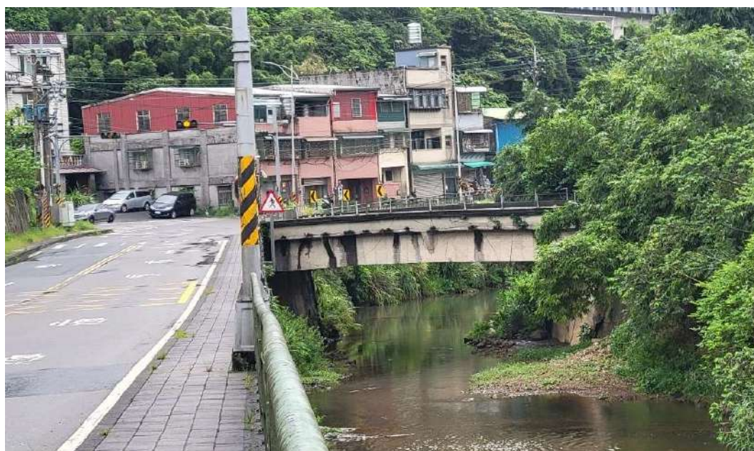
圖 1.1-9 瑪陵坑溪復興橋改建及護岸工程施工圖及現場照片
