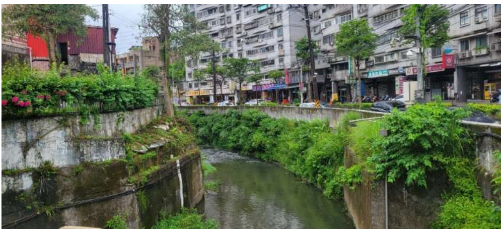
圖 4.1.1 順興橋至民樂橋段改善工程上游段河道現況
