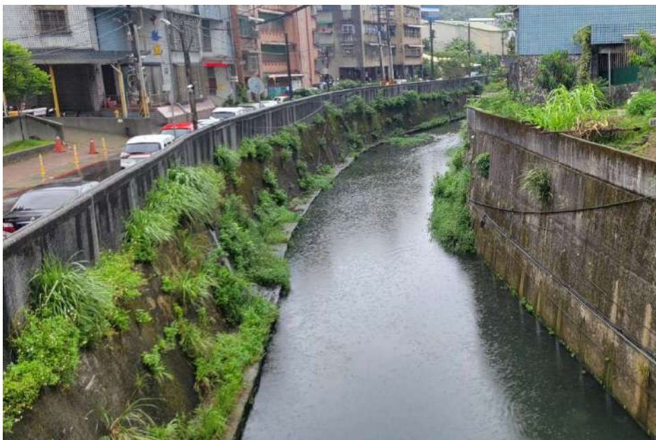
圖 6.1.2 順興橋至民樂橋段改善工程崇崙橋段影像紀錄
