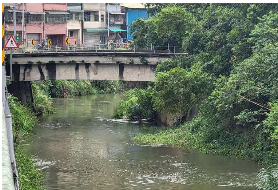
圖 6.1.5 瑪陵坑溪復興橋改建及護岸工程周邊段影像紀錄
