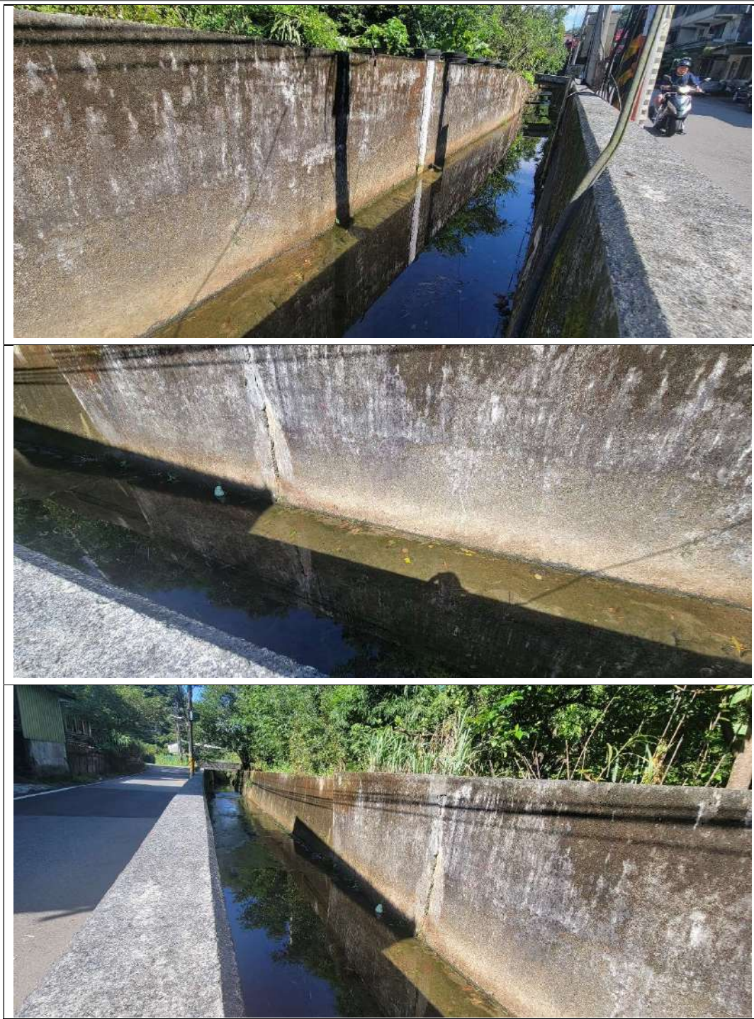
圖 4.1.3 石厝坑溪治理工程河道現況
